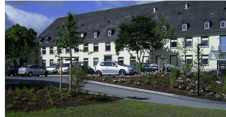
Neues Domizil der Generaldirektion - Kulturelles Erbe - Direktion Archäologie - Außenstelle Koblenz im Gebäude U 1 der ehemaligen Fritsch-Kaserne in Koblenz.
