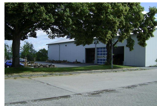
Der Neubau einer knapp 700 m 2 großen Stahlhalle wird als Depotlager und KFZ-Halle benutzt.
