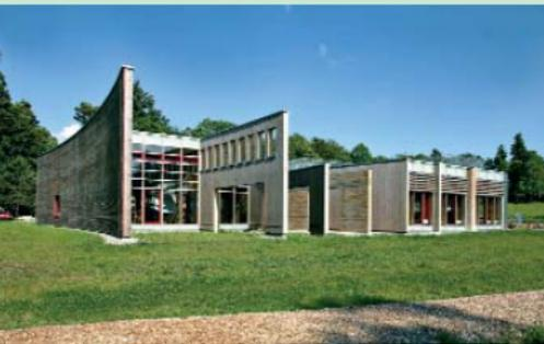
Die begrünte Dachterrasse ist mit einem Sonnenkollektor und Photovoltaikelementen versehen. Glasfassaden tragen zur passiven Nutzung von Sonnenenergie bei, ein Holzpelletsofen sorgt für zusätzliche Wärme und die Toiletten werden mit Regenwasser gespült.
