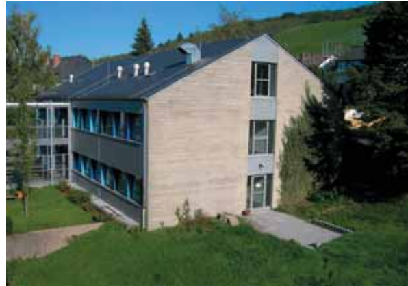
Alles neu: Die MTA-Schule in Trier wurde 2006 umgebaut.
