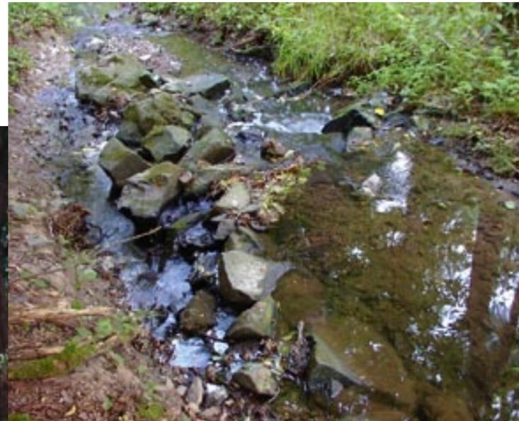
Die Querriegel wurden aus Wasserbausteinen geschüttet und mit bindigem Boden verfüllt, so dass sie eine dichte Sperre bilden. In den Bereichen zwischen den Querriegeln wurde das alte Bachbett aufgefüllt.
