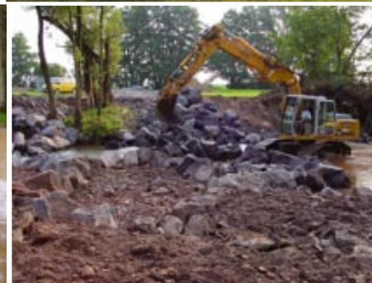
Die Wehrkrone wird abgesenkt, die verbleibende Höhendifferenz mittels einer Sohlrampe in Riegelbauweise überwunden.
