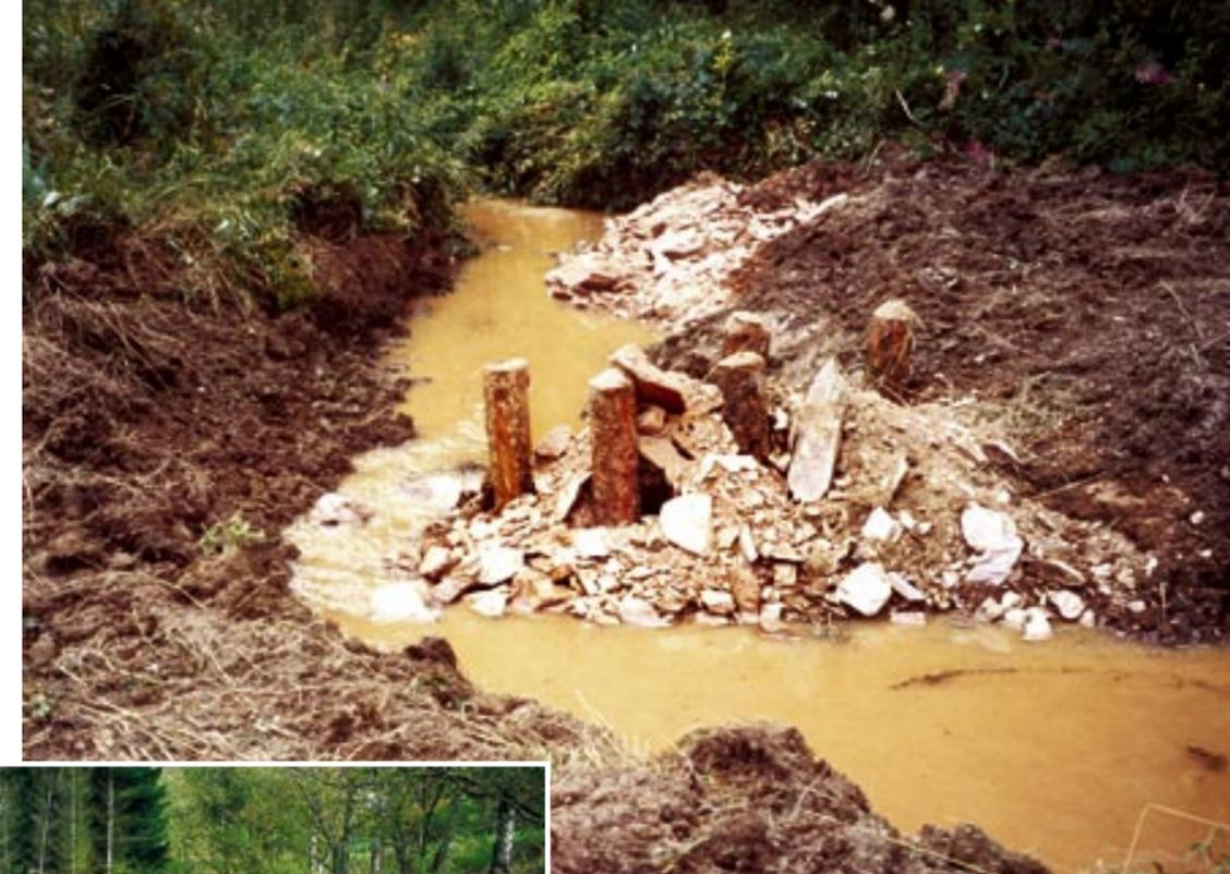
*Mit Holzpfählen und Geschiebe wurde der Gewässerquerschnitt maximal verengt. Die Ufer wurden angerissen. Das Bild zeigt den Zustand während der Bauphase im Sommer 1999.*
