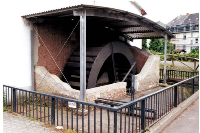
Bild 14: Saniertes und freigelegtes Mühlrad
