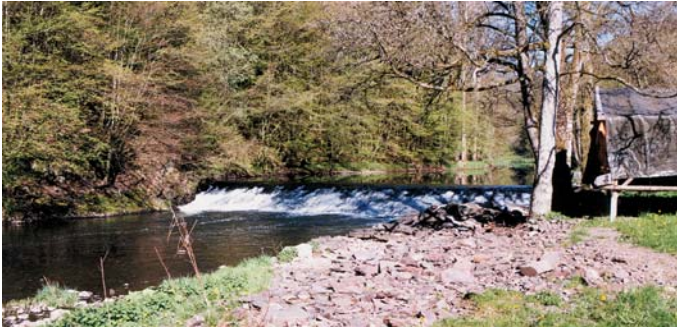
Bild 7: Wehranlage der Schladder Mühle
