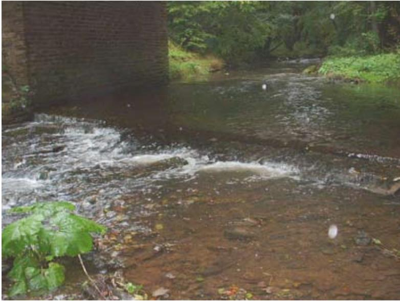
**Abb. 4.9:** Durchlass in der Alf bei niedrigem Abfluss. Der Aufstiegsindex-Querbauwerk für Lachs wurde zu 2 gewählt, da der Durchlass bei höherem Abfluss passierbar ist.
