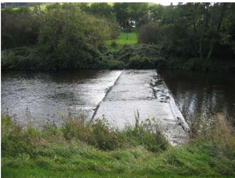
**Abb. 4.6:** Weitere Gleite in der Ahr bei niedrigem Abfluss. Lachse wandern bei höherem Abfluss. Dann ist der Standort passierbar, daher Aufstiegsindex-Querbauwerk für Lachs 2
