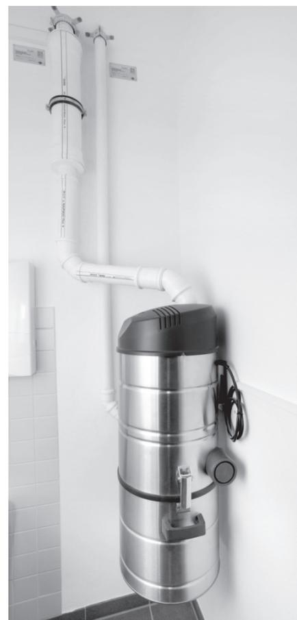
Durch ein Rohrsystem landet der Staub im zentralen Sammelbehälter und gelangt über Abluft ins Freie.
