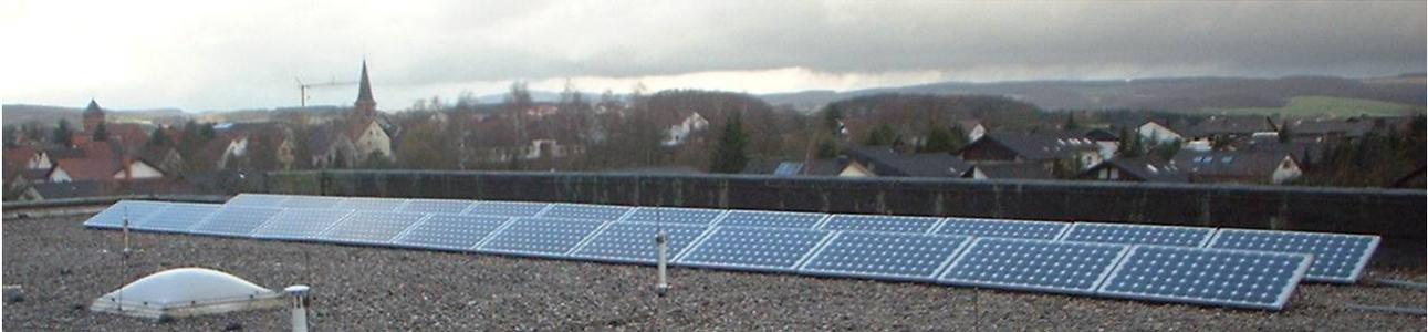
Abbildung 6-5: Flachdachmontage von Photovoltaikmodulen auf der Regionalschule Weilerbach
