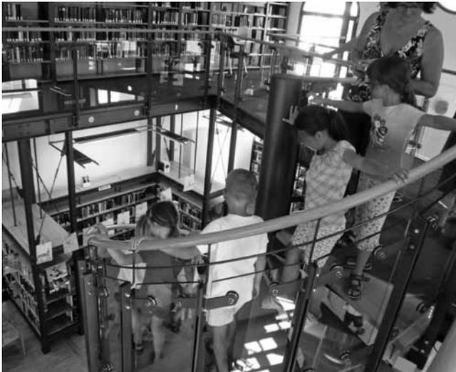
Die Bücherregale sind in die Stahlkonstruktion integriert, eine Wendeltreppe führt in die obere Etage.
