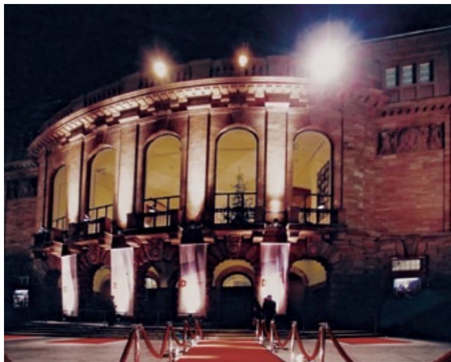
Außenansicht des Mainzer Staatstheaters
