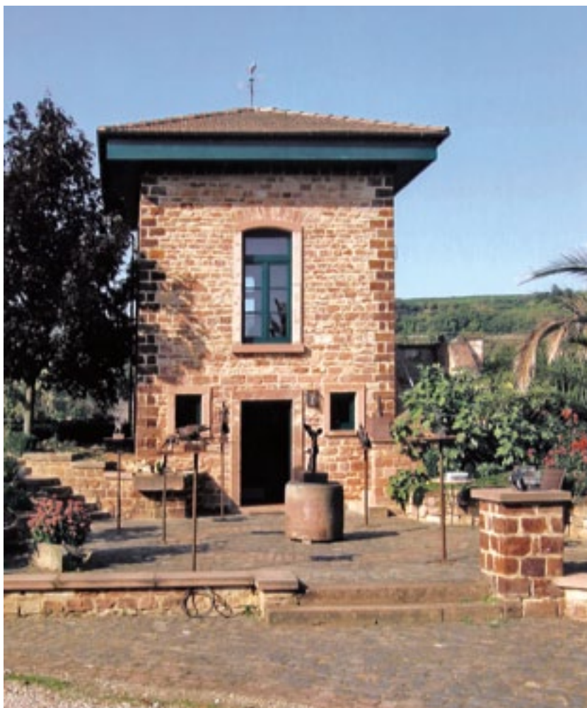
Außenansicht des Turmes in Sausenheim, der das KunstKabinett beherbergt
