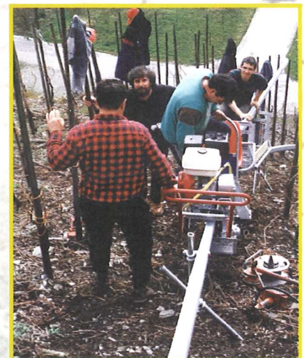
Aufbau einer Monorackbahn
