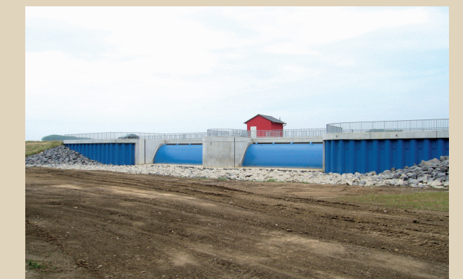
Abb. 4 Ein- und Auslaufbauwerk
