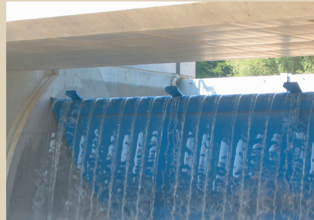
Abb. 6 Fischbauchklappe, Probebetrieb im September 2005
