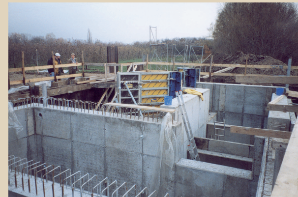
Abb. 10 Schöpfwerk Polderdeich Ost im Bauszustand Okt. 2004
