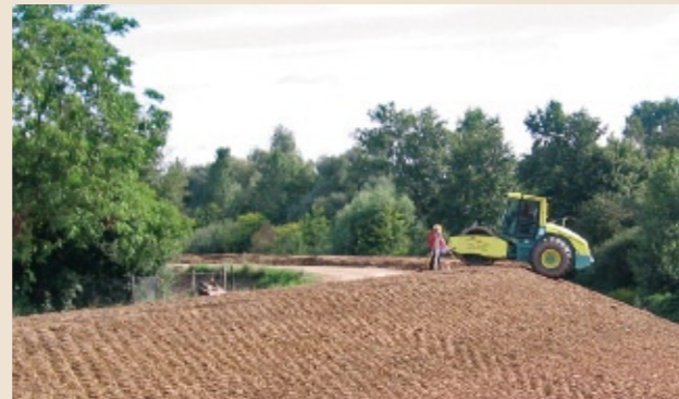
Verdichten der wasserseitigen Deichböschung
