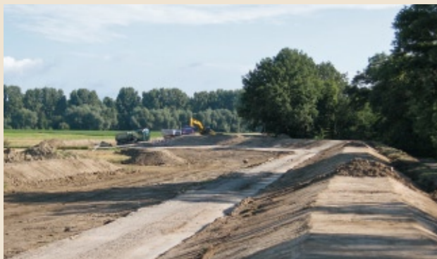
Aufbau des Deichkörpers vor dem Auftrag des Oberbodens
