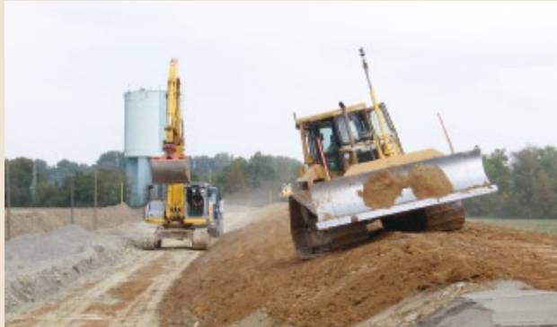
Profilieren des Deichkörpers
