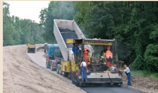
Aufbringen der Trag-Deckschicht auf den Unterbau des Deichunterhaltungsweges
