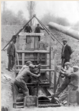
1931: Querung der Überlaufleitung des Wasserwerks Waldsee bei Deich-km 10,86
