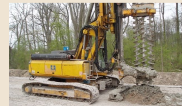
Einbringen der MIP-Wand mittels Schneckenbohrer
