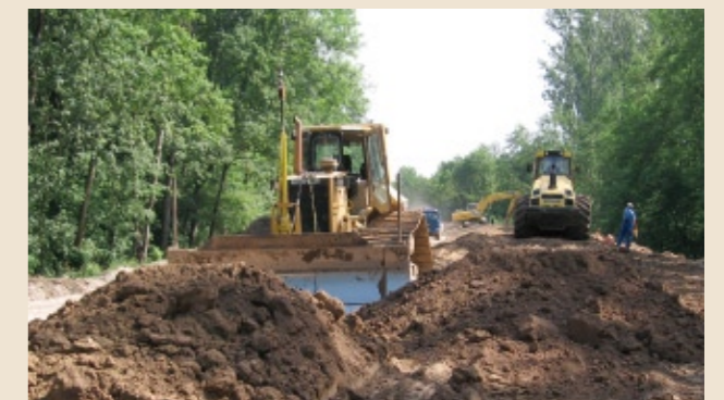
Materialauftrag für den Deichkörper
