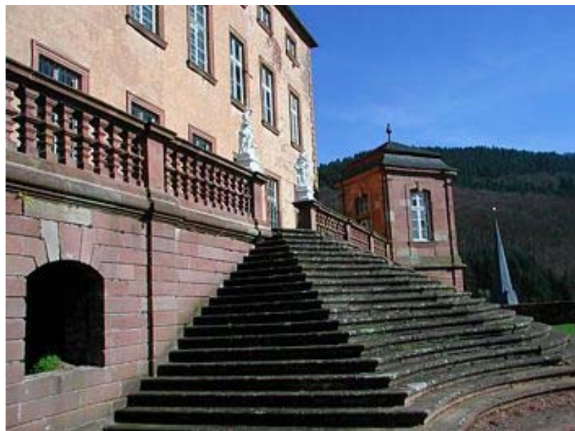
Neues Haus: Freitreppe zur Terrasse und Runden Garten
