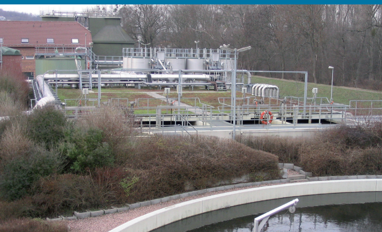
Steigerung der Klärgaserzeugung durch Desintegration; Kläranlage Oppenheim (Ausbaugröße 25.200 E)
