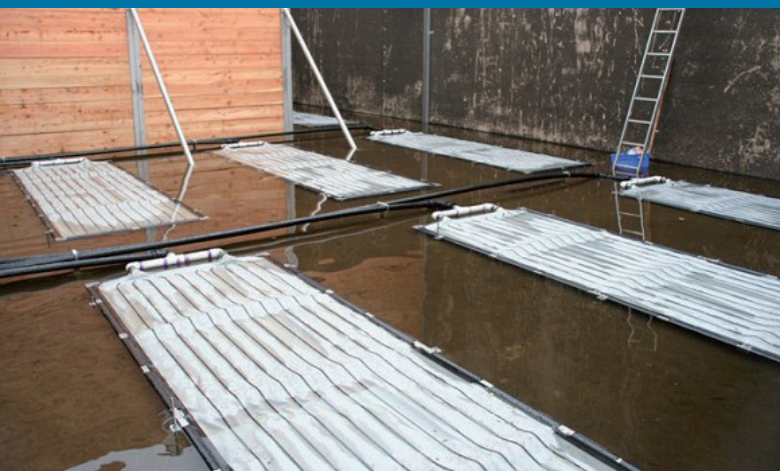
Einbau von Membran-Belüfterplatten, Systemänderung in intermittierende Denitrifikation sowie Regelung mit Fuzzy-Regler; Kläranlage Traben-Trarbach (Weinbaukampagneinfluss, Ausbaugröße 22.000 E)
