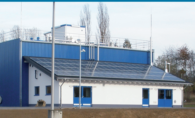
Umstellung von Stabilisierungsanlage auf Schlammfäulung; Kläranlage Linz-Unkel (Ausbaugröße 30.000 E)
