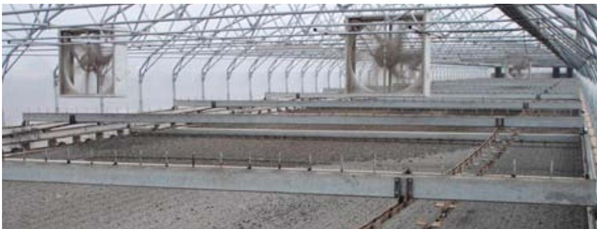
Bild oben: Innenansicht der Halle zur Klärschlamm-trocknung in Hochdorf-Assenheim
