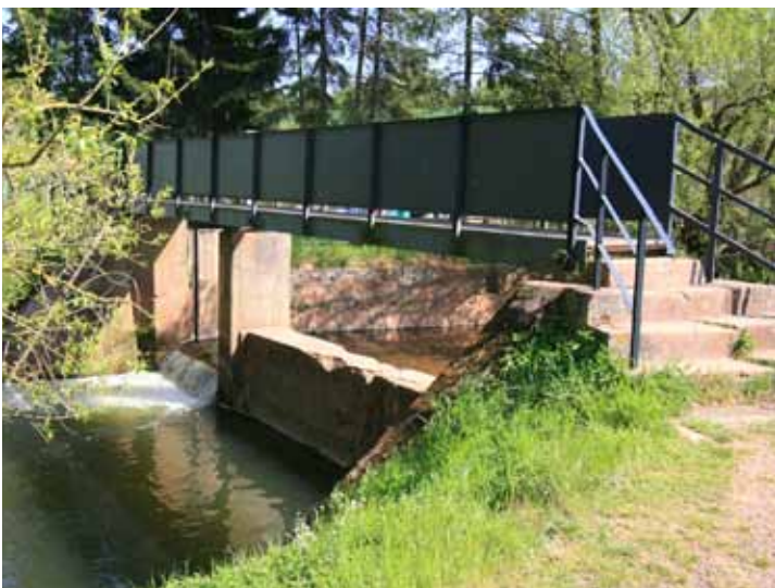
Wehr der ehemaligen Mittelmühle an der Pfrimm vor der Umgestaltung.
