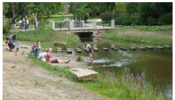
Derselbe Abschnitt wie Abb. Seite 18 im Kurpark nach der Fertigstellung.
