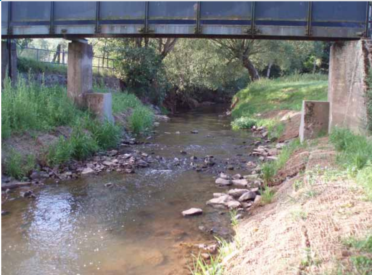
Neue Wanderwege: durchgängige Pfrimm nach der Umgestaltung.
