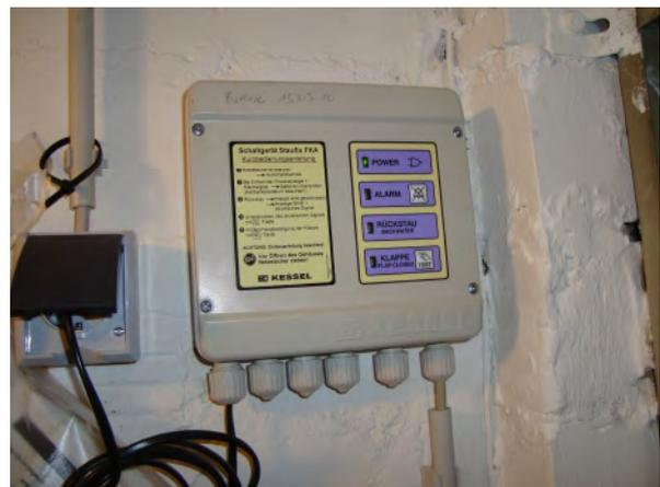
Kontrollgerät einer elektronischen Rückstausicherung, die im Rahmen der Hochwasservorsorge nachgerüstet wurde (Foto: Daniel Hammen)
