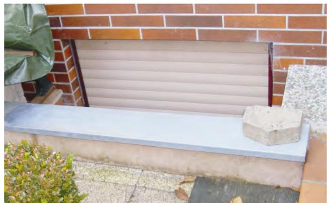
Permanente Erhöhung des Überflutungsschutzes eines Lichtschachts (Foto: Daniel Hammen)
