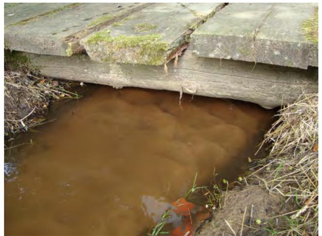
Sedimentablagerungen und Einbauten in das Gewässerprofil führen hier schon bei leicht erhöhten Abflüssen zu Rückstau und Überschwemmungen im Fließgewässer, Aschbach/ Rambach unterhalb von Mölschbach (Foto: Daniel Hammen)
