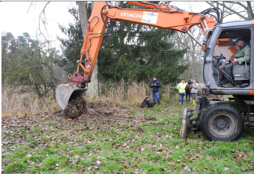
66RPK2013-Alb-NW-WL NSG Neue Wiese – Wasserlacher Hecke Baggerfahrer Hauck beginnt zu graben (P. Jörns)
