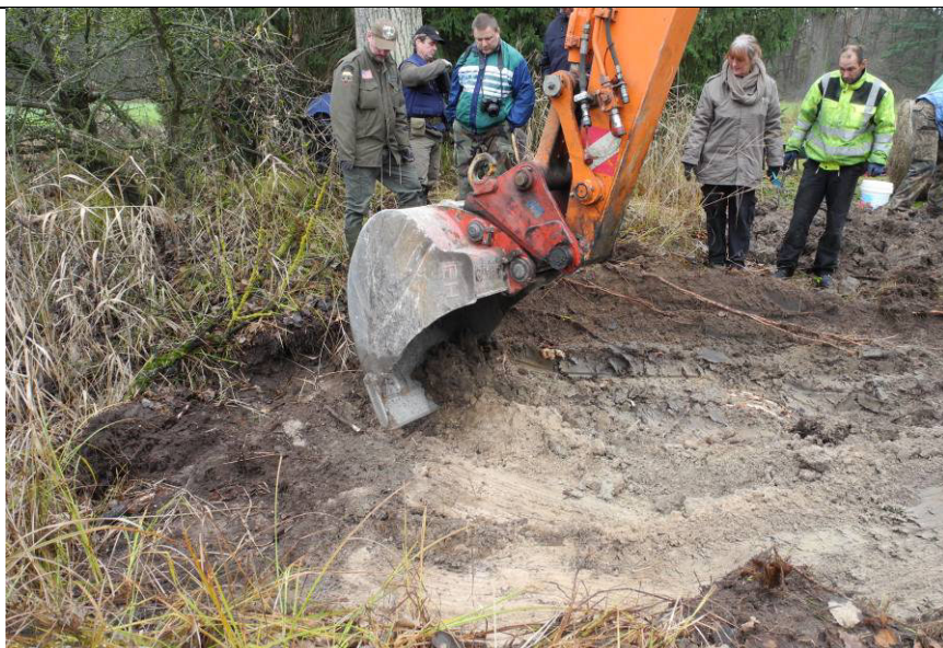
67RPK2013-Alb-NW-WL NSG Neue Wiese – Wasserlacher Hecke Das Loch wächst unter den Augen der Helfer und Schaulustigen (P. Jörns)
