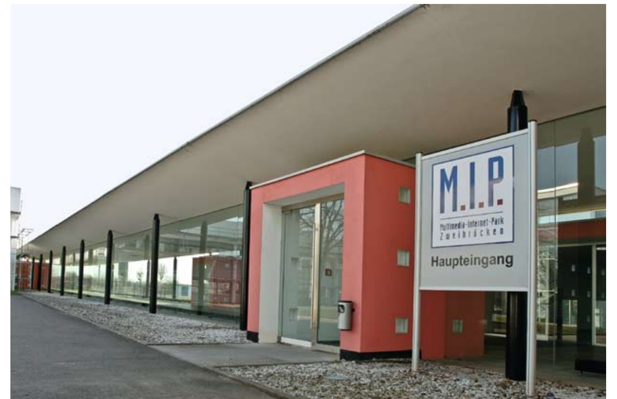
Flughafen Zweibrücken, Eingang MIP
