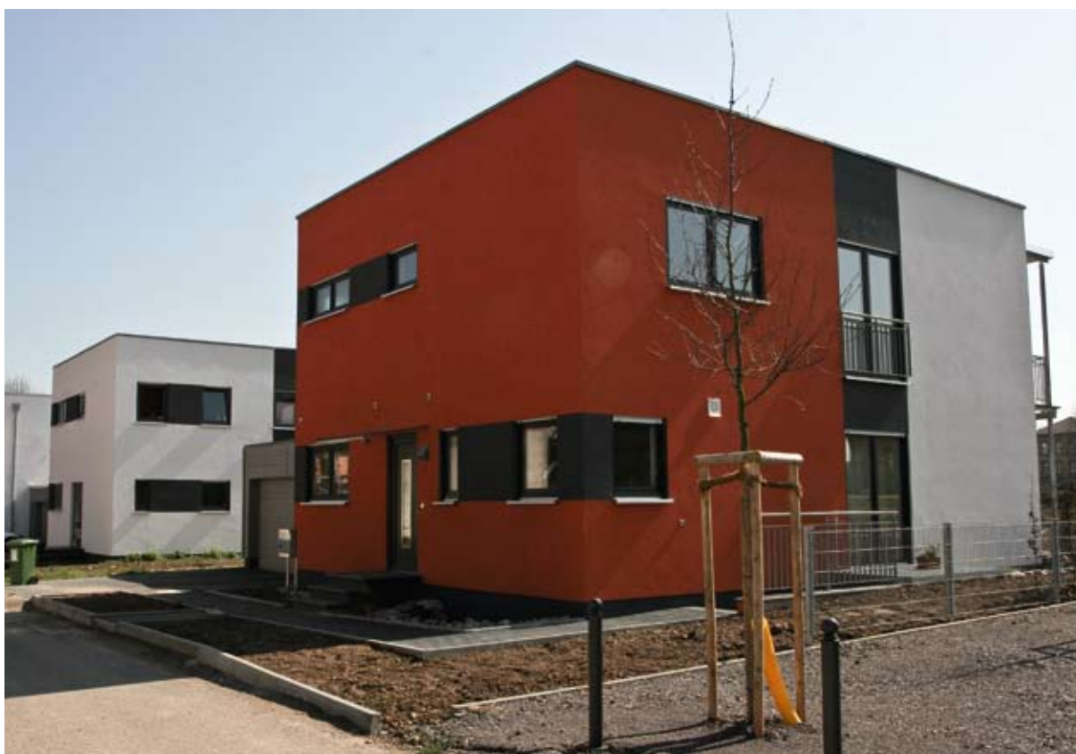
Landau, Quartier Vauban
