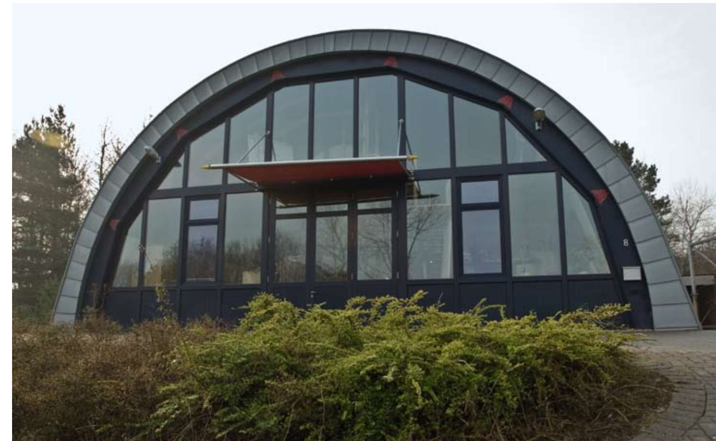
Flugplatz Bitburg, Beispiel für Shelterumgestaltung
