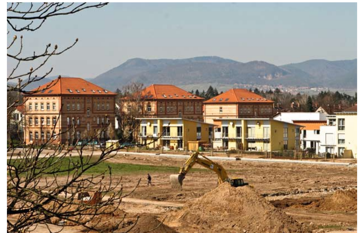
Landau, Quartier Vauban
