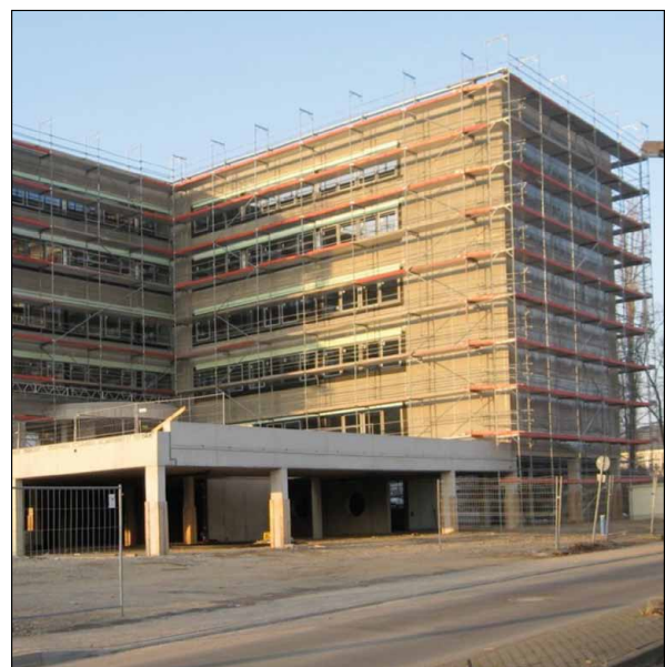
Technologiezentrum im Rohbau
