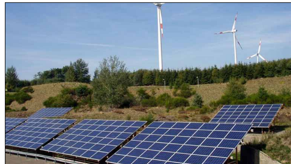
Gewinnung von Solar- und Windenergie
