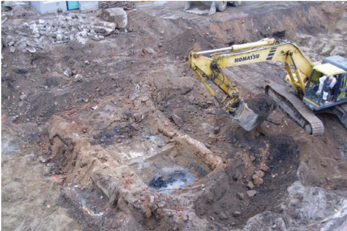
Abb. 48: Sanierung der Teergruben; Quelle: DVGW-EBI
