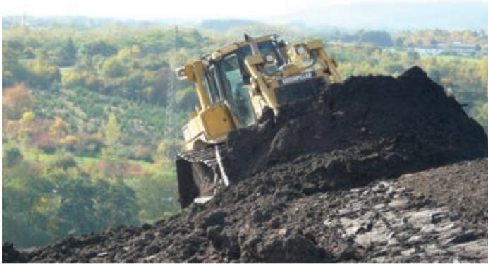
**Abb. 50: Profilierungsarbeiten vor Aufbringung der Oberflächenabdichtung einer Deponie**
