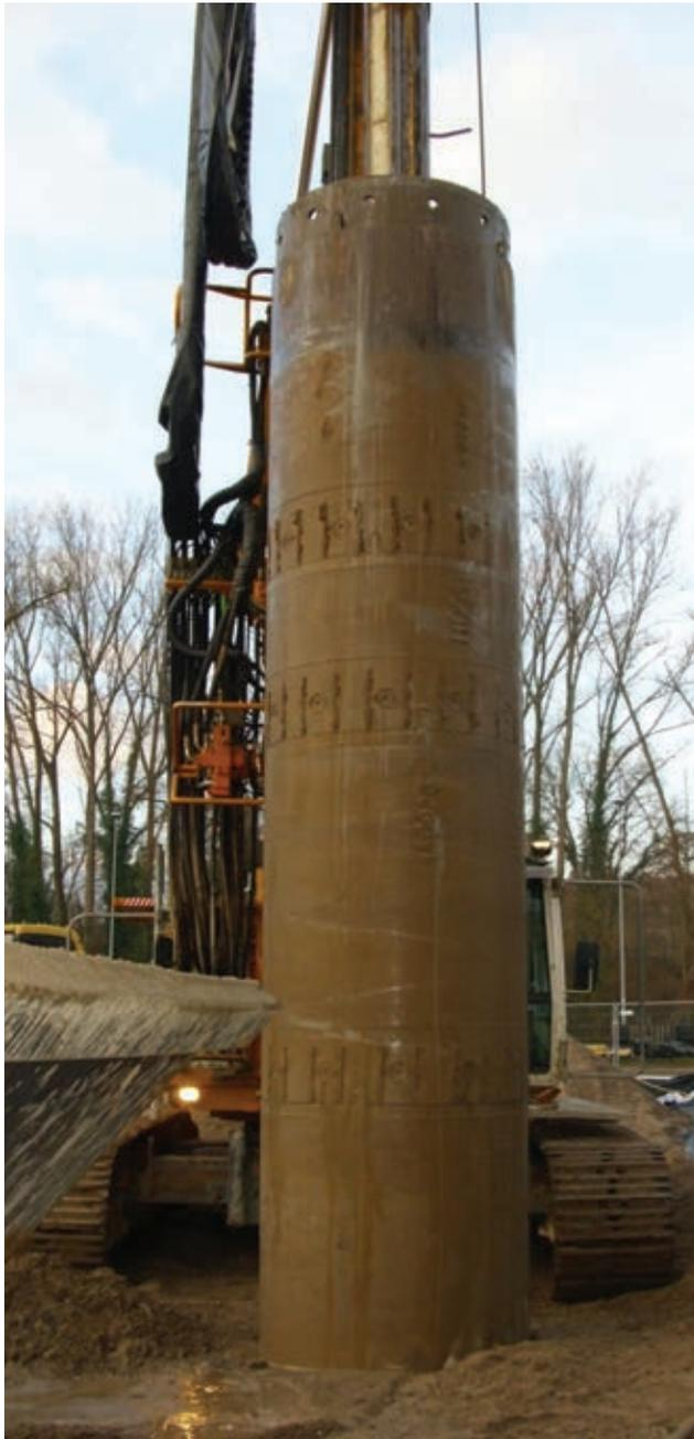
Abb. 47: Großlochbohrgerät; Quelle: DVGW-EBI
