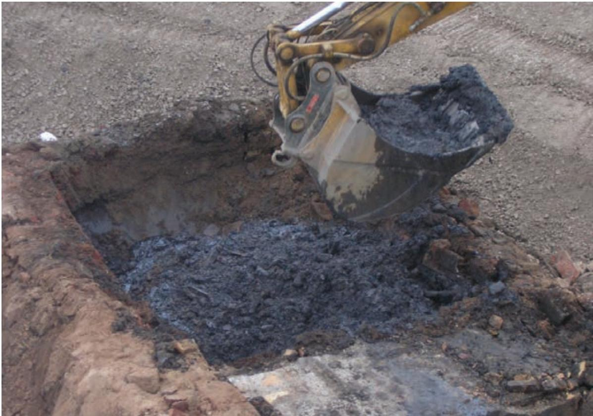
**Abb. 46: Freilegung der Teergruben**
