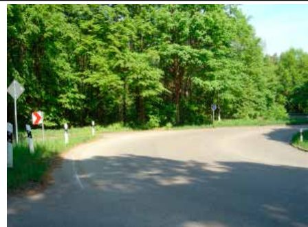
K 13 Beginn des Straßenbegl. Radweges im Kurvenbereich
