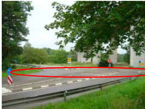
Möglichkeit der Furtmarkierungen an der Querung der L 470 an der Kreuzung L 395/ L470
