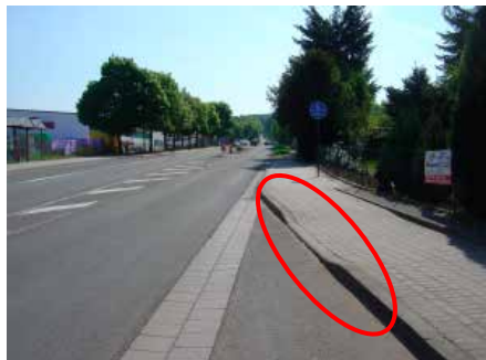
Rodenbach: Beginn / Ende des Straßenbegleitenden Radweges => Bordsteinabsenkung zum Fahrbahnwechsel ist nicht optimal und das VZ 240 sowie das Zusatzzeichen „Radweg Ende“ fehlen
