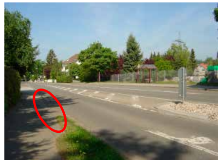
Rodenbach: Vorschlag den Beginn / das Ende des Radweges an diese Stelle zu setzen => Nullabsenkung vorhanden und der Radweg ist weg aus der Busbucht
