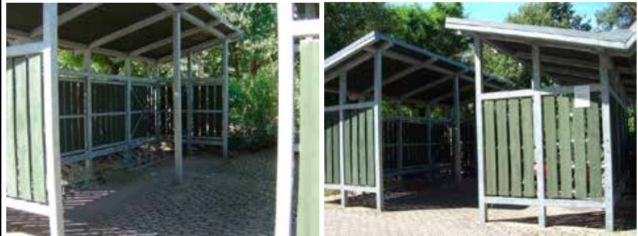
überdachte Fahrradabstellanlage am Bahnhof in Schopp
