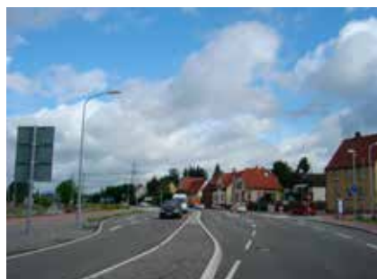
Otterbach: K 62 zwischen neuem Kreisel und L 389 in Fahrtrichtung Katzweiler
