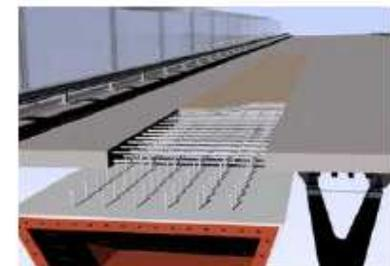
Für den Entwurf der Durchlaufträger und der Y-Stützen wurde Corten Stahl gewählt, um die langfristigen Wartungsarbeiten zu minimieren. Durch den Einsatz von Corten Stahl entfällt die Anforderung für einen internen Anstrich der Durchlaufträger und erleichtert somit die Wartung wesentlich.
