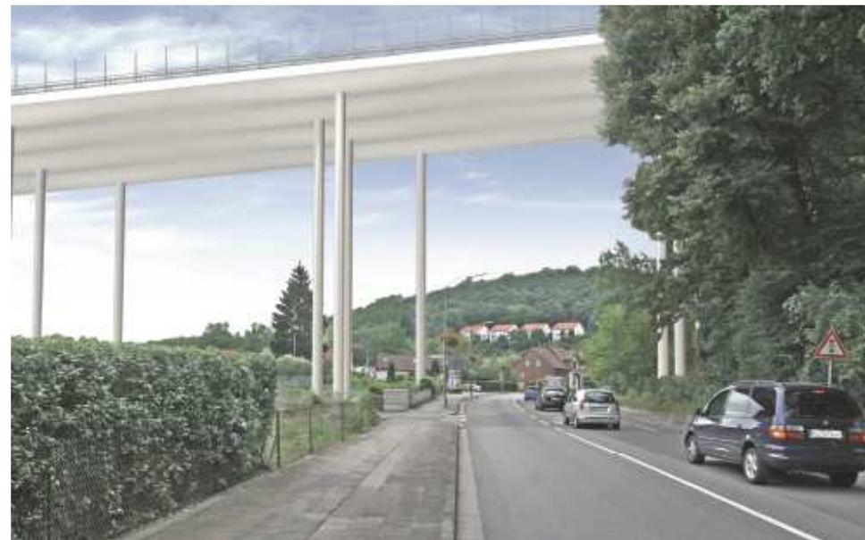
Sollten es zeitliche oder baubetriebliche Gründe erforderlich machen, so kann wegen der weitgehenden Symmetrie des Bauwerks die Fertigungsrichtung ohne Probleme gewechselt werden. In diesem Fall beginnt der Bau in Achse 50 und die Längsfesthaltung liegt im Endzustand in Achse 0. In diesem Falle werden dann die Stützen in Achse 8 als Pendelstütze ausgeführt. Dies hat auch den Vorteil, dass keine Pendelstützen im Gefahrenbereich der Bahntrasse stehen.
