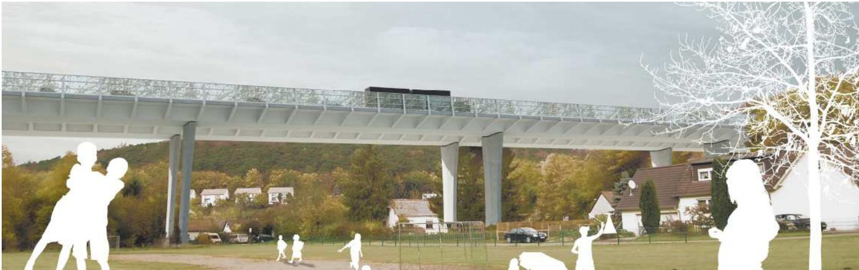
Um dies zu erreichen, werden die bis zu 27 m hohen Pfeiler mit den Überbauten monolithisch verbundenen, womit sich für das Bauwerk ein statisch günstiges ganzheitliches Tragverhalten einstellt. Wartungsintensive Lager auf den Pfeilern entfallen für die gewählte Bauweise vollständig.
