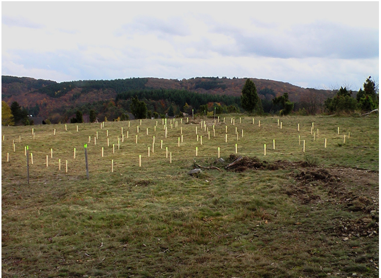
Bild 1: Zustand des Heidegartens am 28.10.2008. Der Gartengrundriss ist eingemessen und mit Stöcken markiert, die Fläche gemäht und die Weggrasse mit dem Bagger freigeschaufelt.
