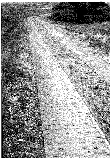
Betonsteinplatten als Spurbahn verlegt
