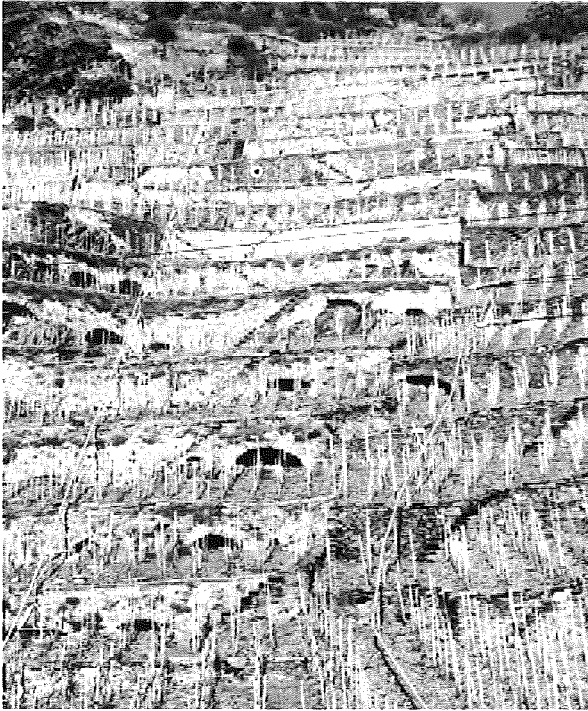
Abb. 3: Trockenmauern im Uhlen
