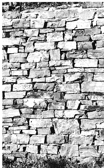
Abb. 5: Eine perfekte Mauer aus Quarzit von Treis
