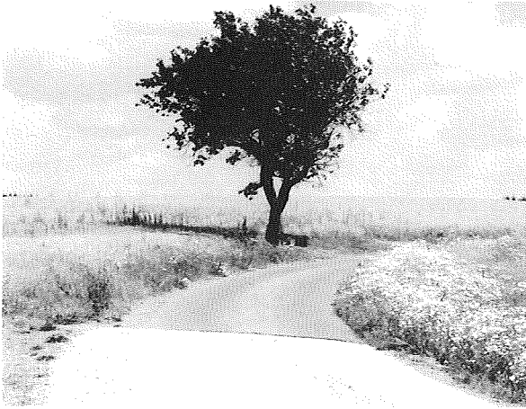
Übergang von der Bitumendecke zur Hydraulisch gebundenen Tragdeckschicht (HGTD)
