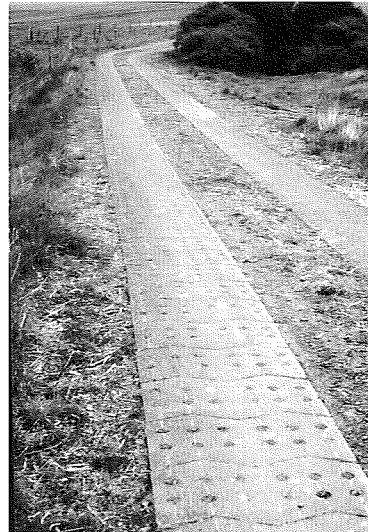
Betonplattenspur
