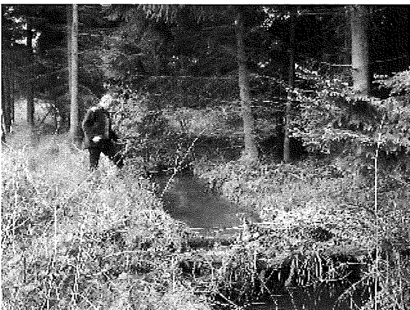
Abb. 3: Entfichtungsarbeiten am Rachter Bach
