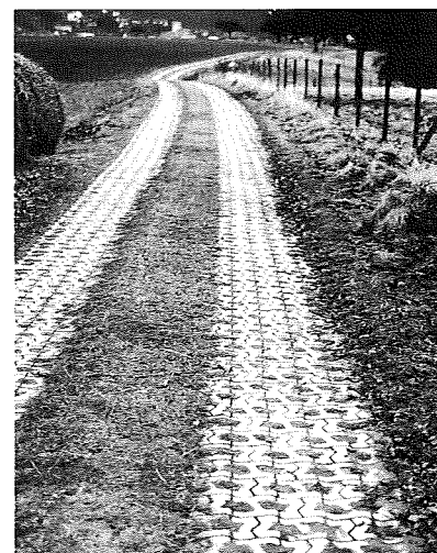
Rasenverbundsteine Unni-2N wie zuvor
