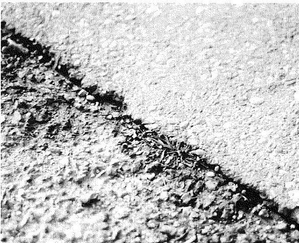
Übergang von der Bitumendecke zur Hydraulisch gebundenen Tragdeckschicht (HGTD)
