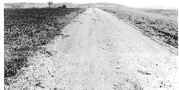
Vollflächige Versiegelung mit Bitumen
