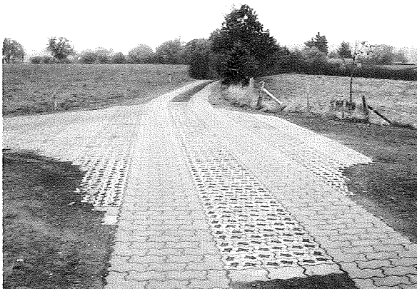
Betonverbundstein-Spurbahn mit Rasenverbundpflaster in der Mittelspur und im Kreuzungsbereich
