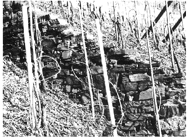
Abb. 13: Flügelmauer
