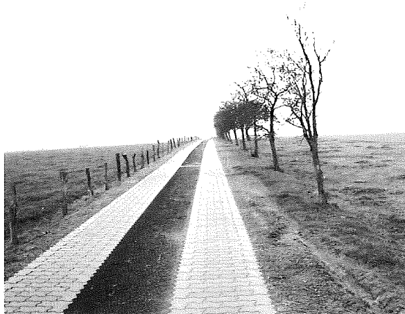
Betonverbundstein-Spurbahn mit Rasenverbundpflaster in der Mittelspur und im Kreuzungsbereich
