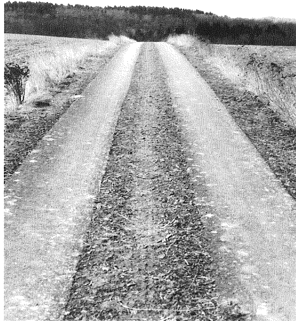
Übergang von der Bitumendecke zur Hydraulisch gebundenen Tragdeckschicht (HGTD)
