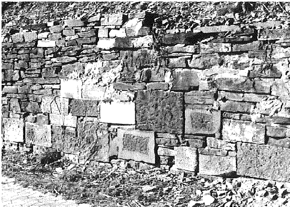
Abb. 22: Steine aus Plaidter Basalt in einer Trockenmauer, meist Grabsteine nach G. Löwenstein, Winnigen
