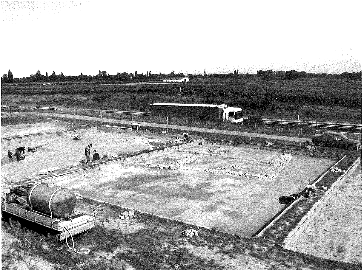
Abb. 4: Übersicht über die Fundamentreste des Nebengebäudes
