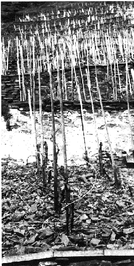
Abb. 9: Abschluss der Mauern
