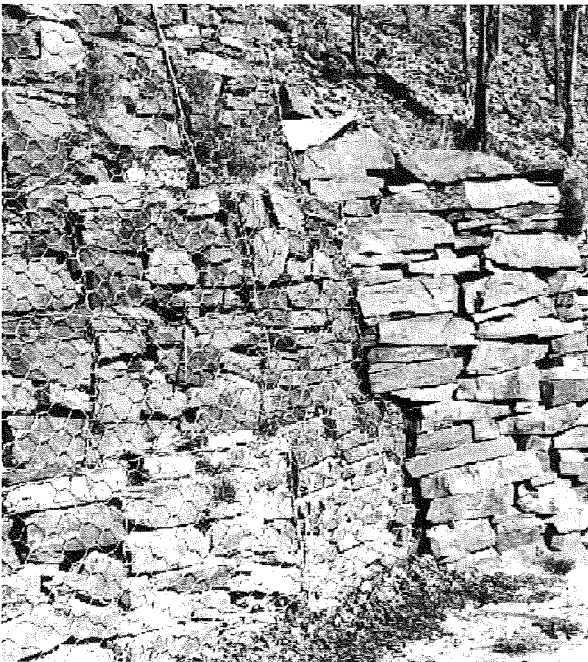
Abb. 7: Gabionen-Mauer mit Mäusepromenaden und Mauerpfusch
