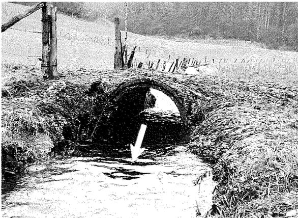
Abb. 6: Abschnitt 27 - Rohrdurchlass NW 100
