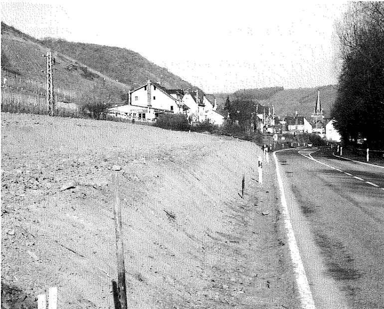
Abb. 4: Ersatz für Mauerbau
