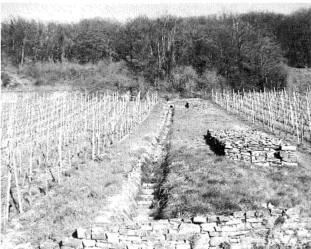
Abb. 5: Gewässerausbau: Kaskaden und Geröllsperre
