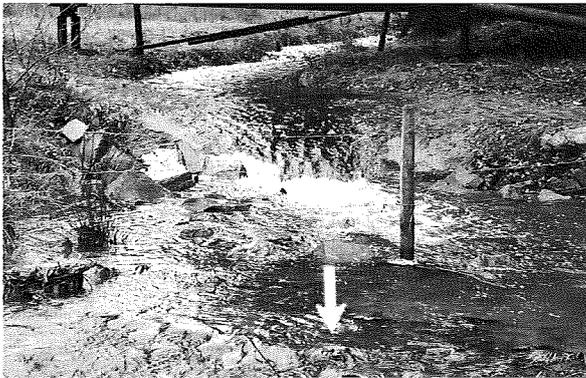
Abb. 5: Abschnitt 25 - Gepflasterte Furt mit Sohlabschurz
