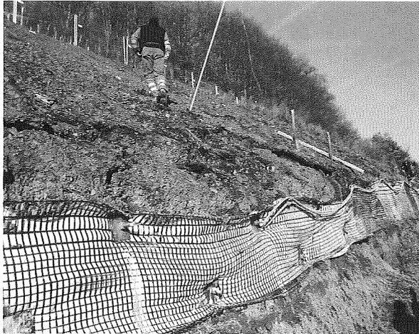
Hier war die Kohäsion der Böden so stark vermindert, so dass die zum Herstellen des Spritzbetonriegels erforderliche Standsicherheit selbst bei der geringen Höhe der Aushubwand von ca. 1 m bereichsweise nicht gegeben war.
