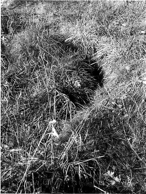
Abb. 7: Ausmündung der Längssickerung mit einem kurzen Graben
