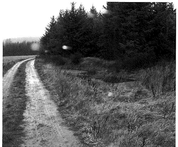
Abb. 13: Versickerungsmulde mit Dauerstau, aber ohne Notüberlauf
