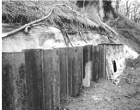
Lediglich, die bereits in Angriff genommenen äußeren Riegelabschnitte wurden in Spritzbetonbauweise hergestellt.
