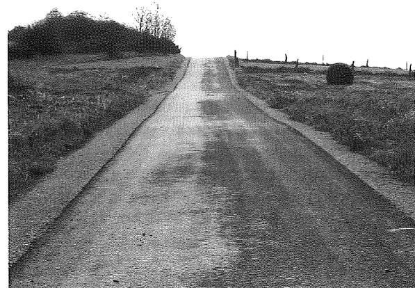
Abb. 2: An dem Wechsel feucht/trocken ist zu erkennen, dass das Wasser infolge des Quergefalles in Richtung Bankette fließt.
