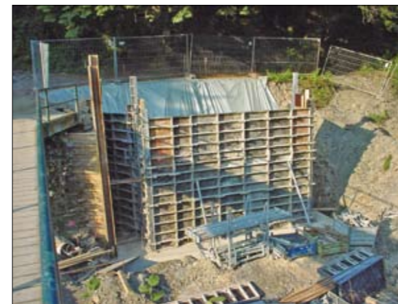
Abb. 6: Vorarbeiten für die Erstellung der neuen Brückenfundamente.
