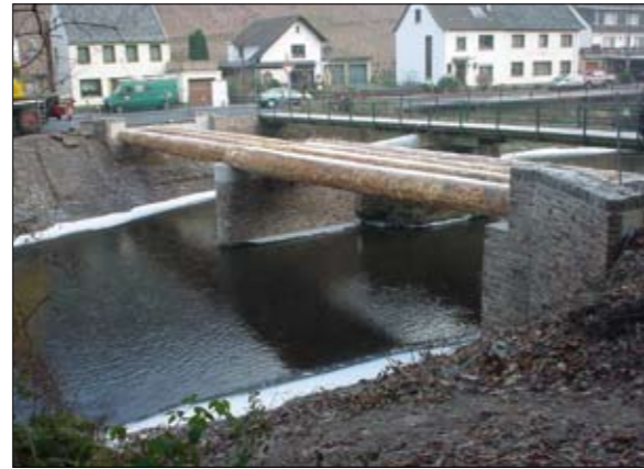
Abb. 12: Im Querschnitt sind die fünf Rundholzstämmе zu erkennen, die in Längsrichtung der Brücke verlaufen. Nur die Stuhlstützen stehen auf HEB-200 Stahlträgern.
