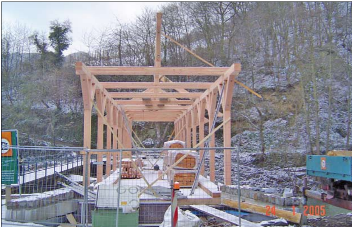
Abb. 17: Brückenaufbau und Dachkonstruktion (schrittweise Entstehung).
