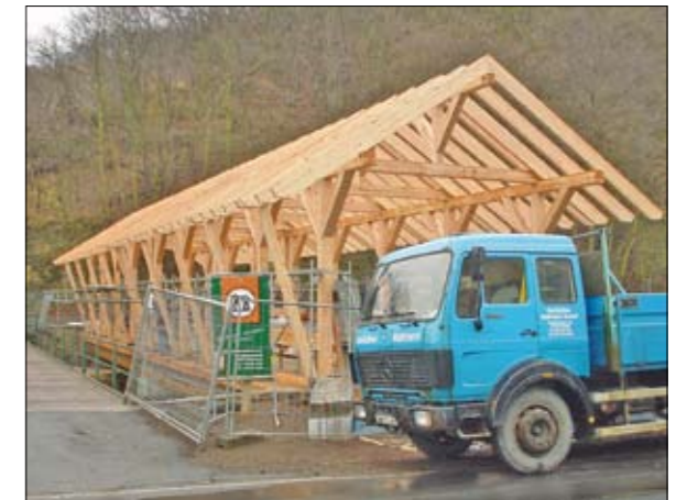
Abb. 21: Brückenaufbau und Dachkonstruktion (schrittweise Entstehung).
