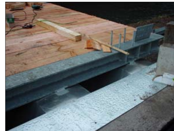
Abb. 14: Als Abdeckung und an den hoch belasteten Stellen der Stützenfüße ist Metall eingesetzt worden.
