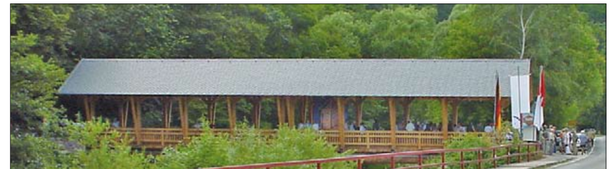
Abb. 22: Die Deckung des um 33° geneigten Satteldaches besteht aus Schiefer.
