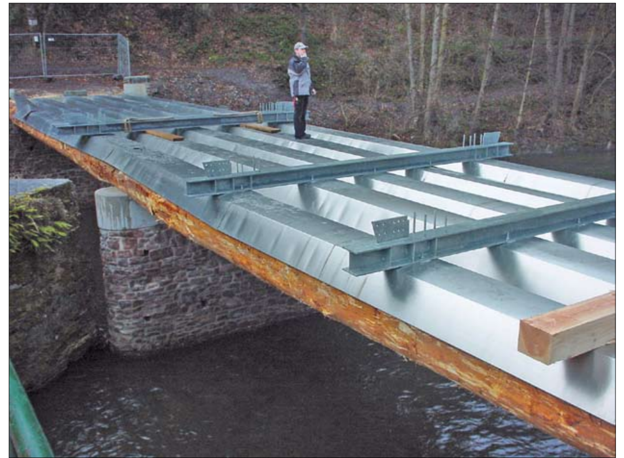
Abb. 13: Zum Schutz vor Schlagregen ist eine Blechabdeckung verlegt worden.
