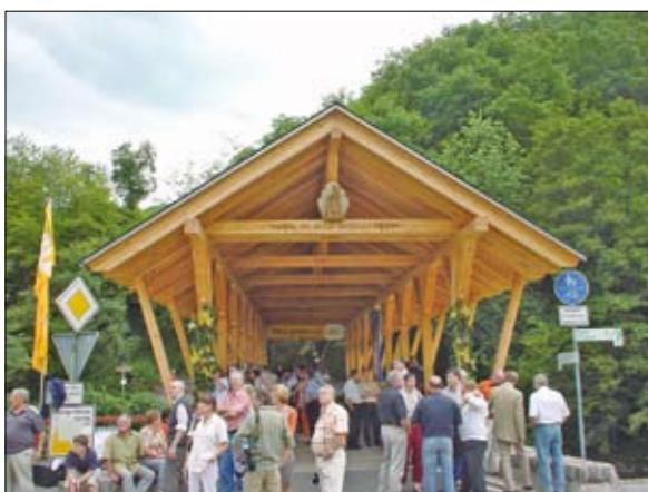
Abb. 23: Die St. Anna-Brücke ist zwar nur eine von etwa 10 weiteren Holzbrücken der Ahr - aber mit Sicherheit eine der schönsten.
