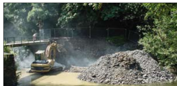
Abb. 3: Vorarbeiten für die Erstellung der neuen Brückenfundamente.
