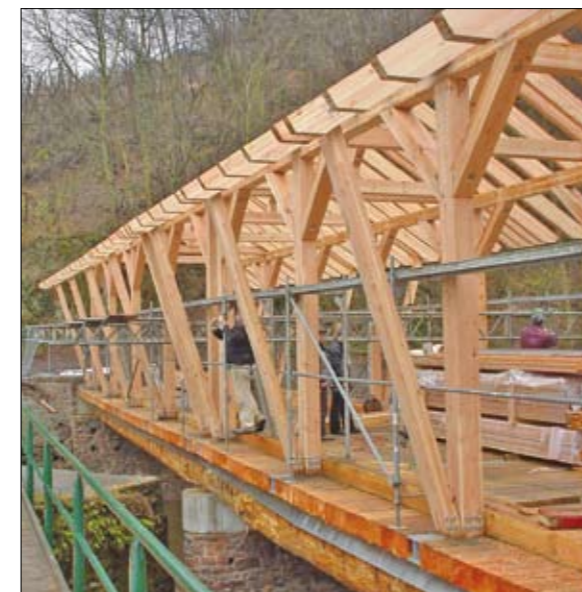
Abb. 20: Brückenaufbau und Dachkonstruktion (schrittweise Entstehung).
