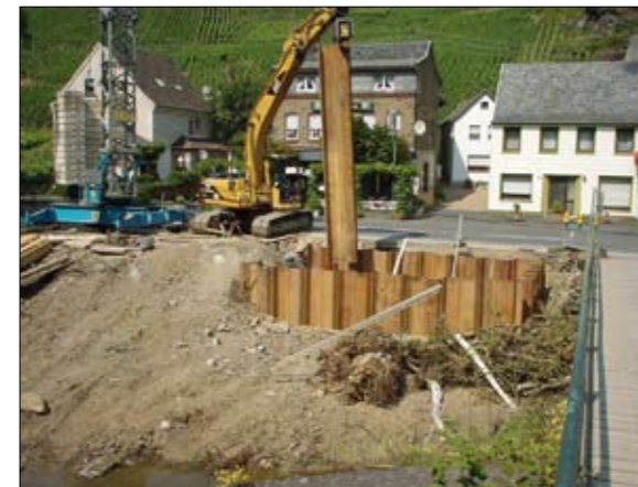
Abb. 4: Vorarbeiten für die Erstellung der neuen Brückenfundamente.
