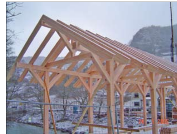
Abb. 18: Brückenaufbau und Dachkonstruktion (schrittweise Entstehung).
