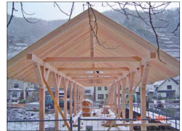
Abb. 19: Brückenaufbau und Dachkonstruktion (schrittweise Entstehung).
