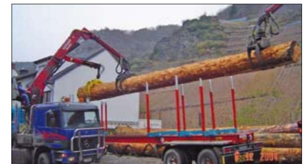
Abb. 9: Einbau der vorgefertigten Rundholzstämmen.
