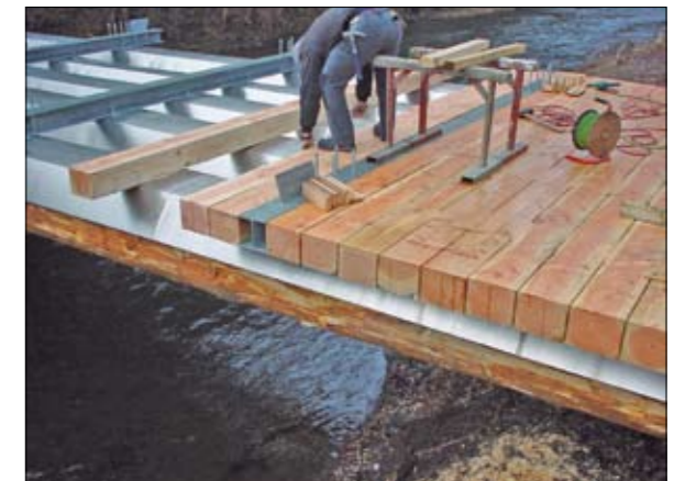
Abb. 15: Die Fahrbahnbohlen haben auch aussteifende Funktion.
