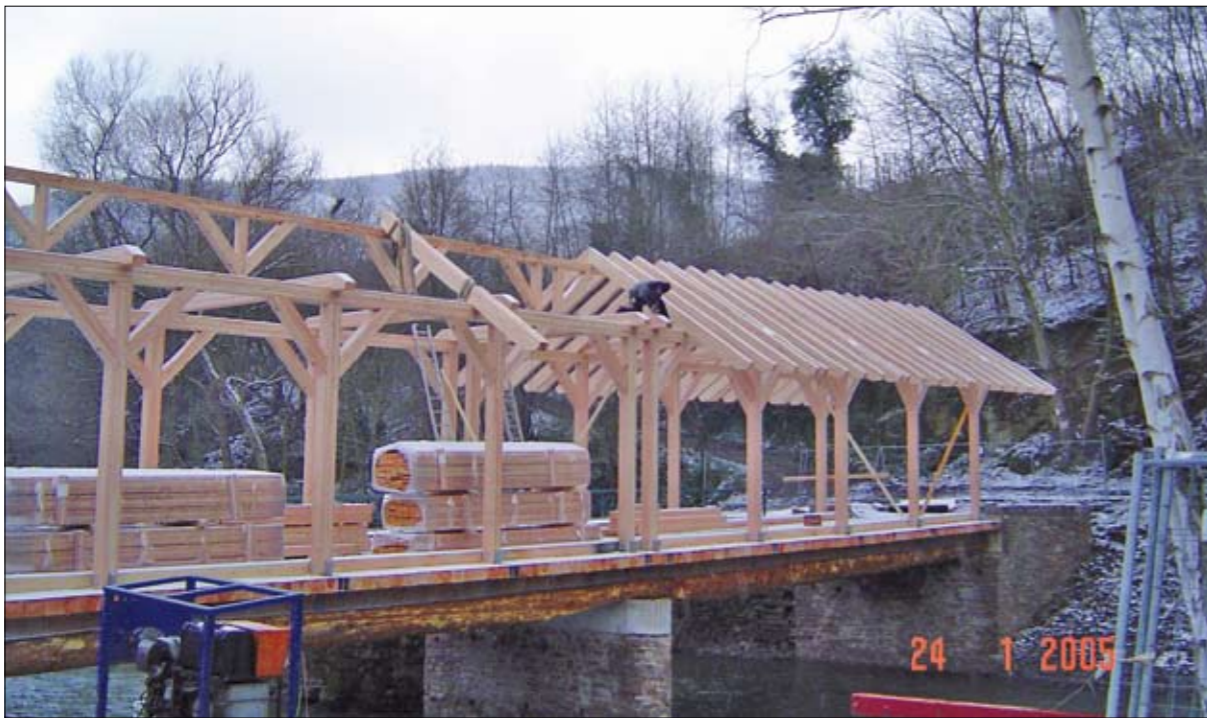
Abb. 16: Brückenaufbau und Dachkonstruktion (schrittweise Entstehung).
