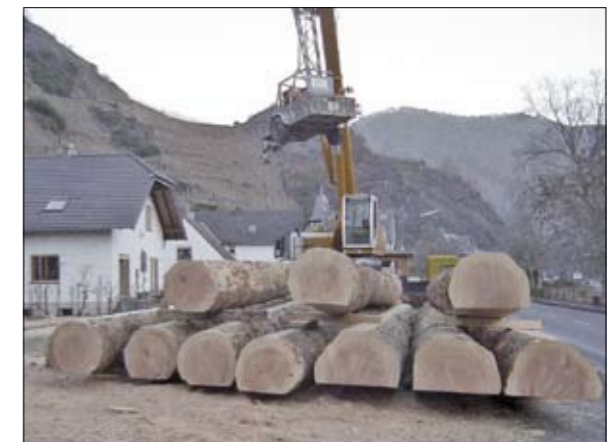
Abb. 7: Angelieferte, vorgefertigte Rundholzstämmen.
