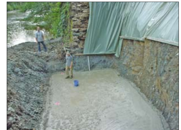
Abb. 5: Vorarbeiten für die Erstellung der neuen Brückenfundamente.
