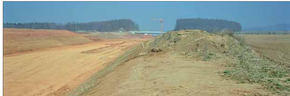
Abb. 2: Die Autobahntrasse im Erdbau
