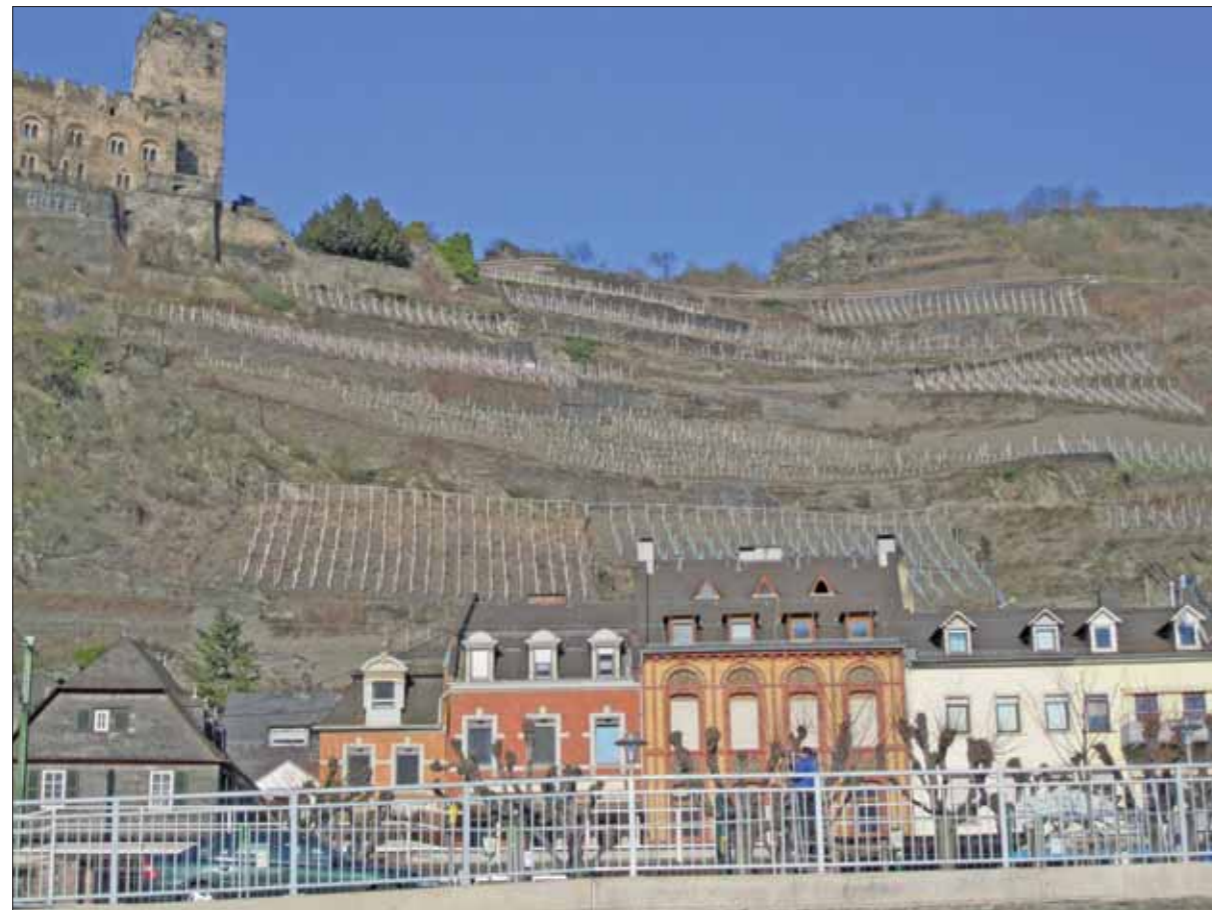
Abb. 2: Kaub-Gutenfels: Reaktivierung der Burgweinberge durch Wegerschließung und Mauersanierung
