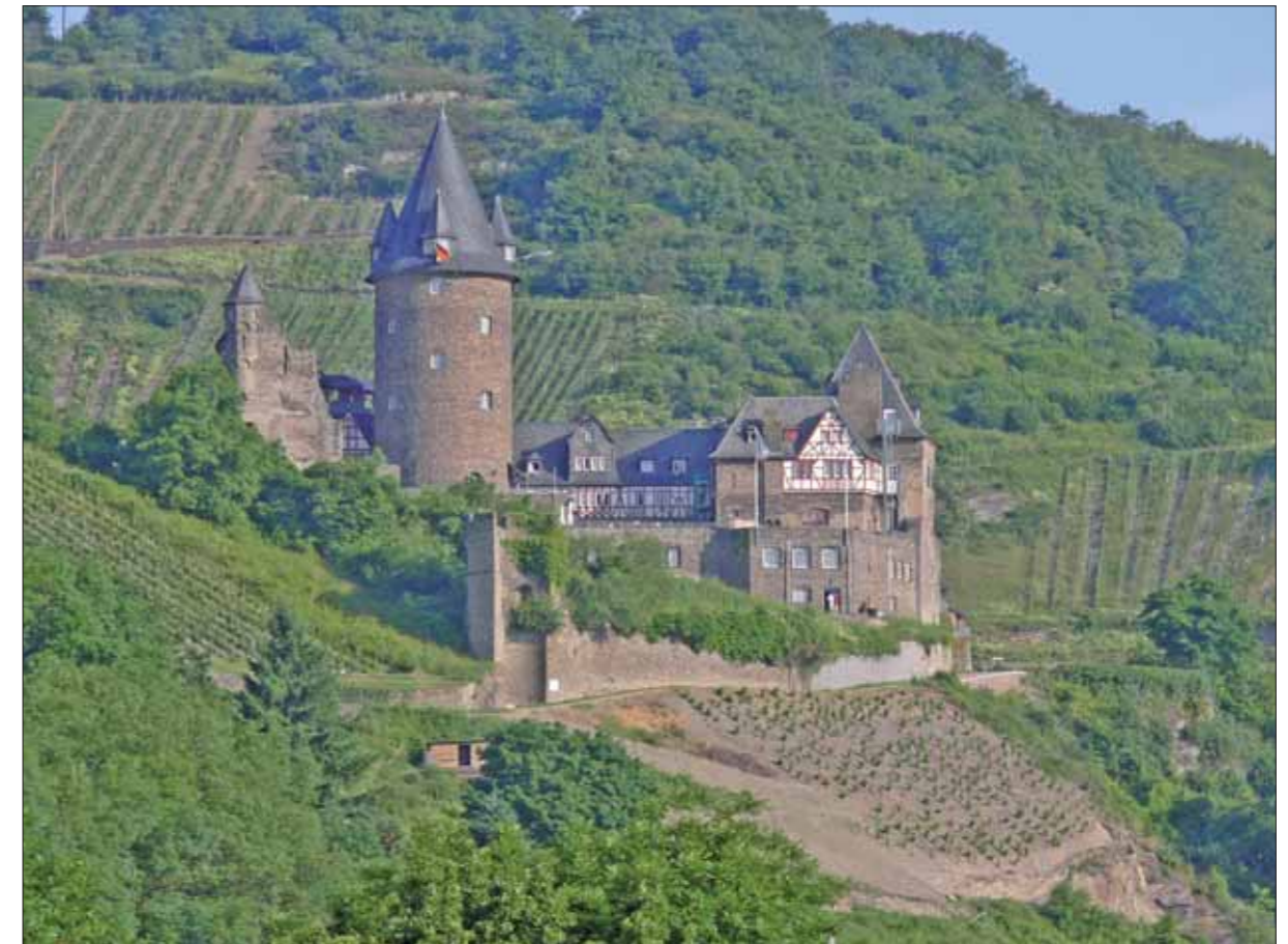
Abb. 3: Bacharach-Stahleck: Vergrößerung der Weinbergsflächen um die Burg in Kombination mit Sanierung der Stadtmauer am Stadtmauerrundweg
