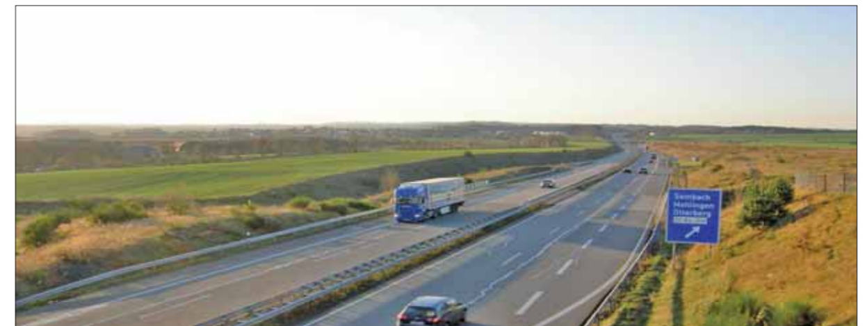
Abb. 1 : Die Autobahn A 63 in Höhe der Anschlussstelle Sembach, Blick in Fahrtrichtung Kaiserslautern
