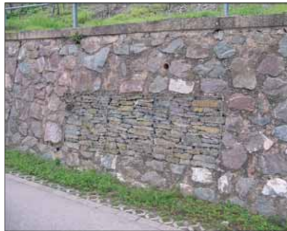
Abb. 3: Zu klein dimensionierte Rohre und Gabionenfenster ohne grabbares Material werden kaum angenommen
