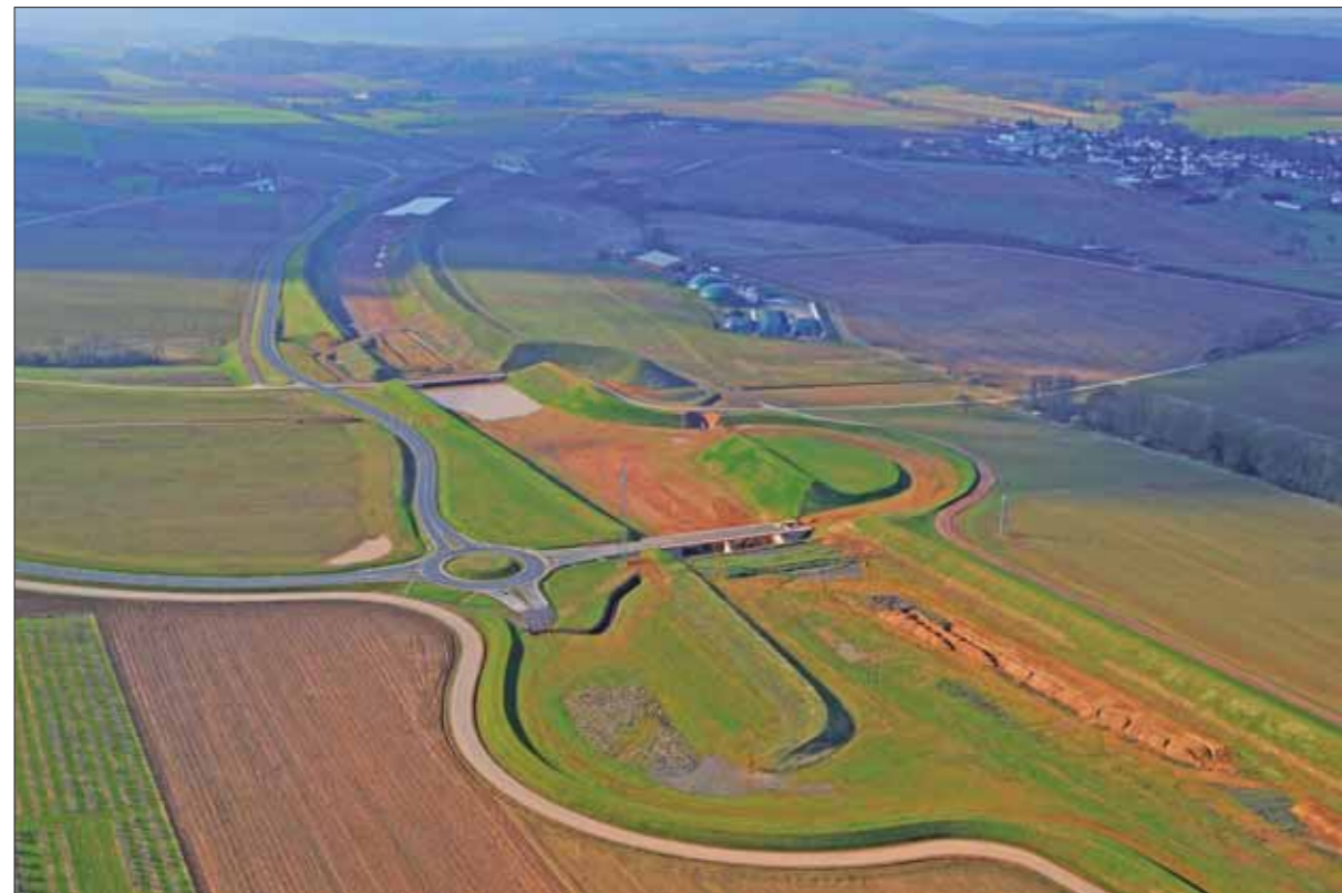
Luftbild „Kreisverkehrsplatz“ zwischen Altrich und Platten mit Anschluss der L53n „Quelle: Landesbetrieb Mobilität Trier / www.hochmoseluebergang.rlp.de “
