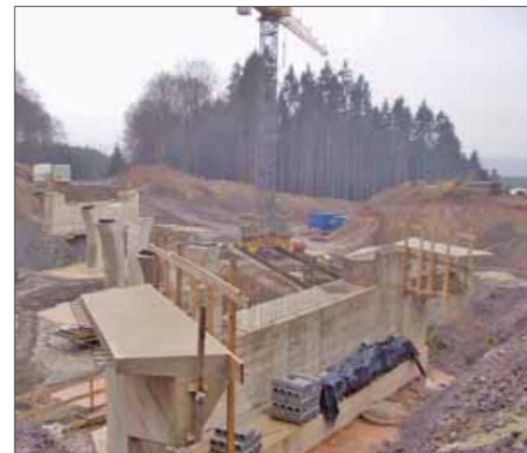
Abb. 2: Bau eines Kreuzungsbauwerkes Autobahn - Bundesstraße
