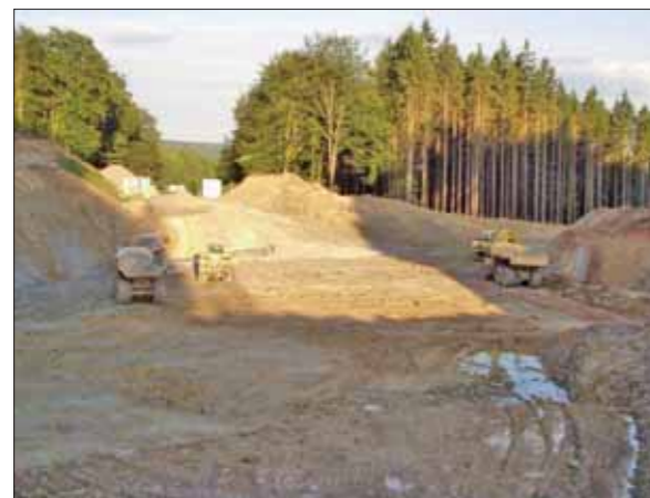
Abb. 1: Autobahn im Bau
