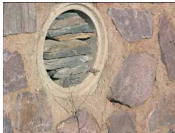
Abb. 4: Ausreichend dimensionierte Rohre mit eingelegten Schieferplatten und grabbarem Material werden gut angenommen
