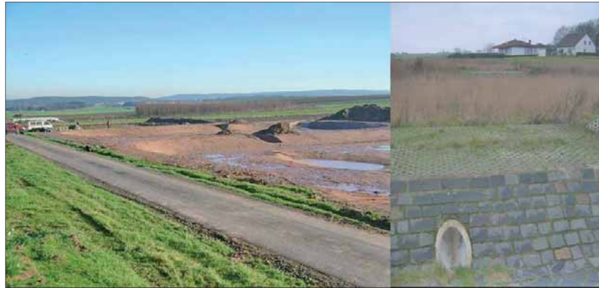
Abb. 12: Rückhaltebecken während der Bauphase und nach der Fertigstellung
