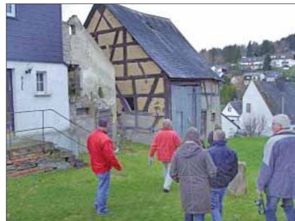
Abb.:3: Abriss oder ortsbildprägende Bausubstanz?
