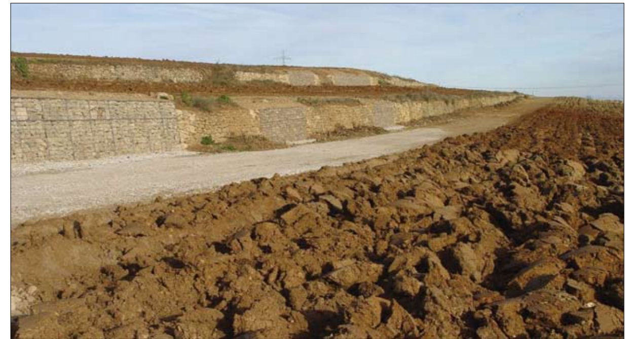
Abb. 16: Nach der Instandsetzung
