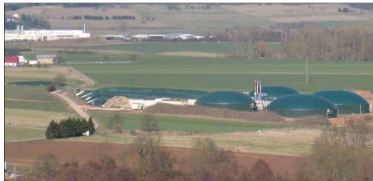
Abb. 8: Blick auf die Biogasanlage Platten
