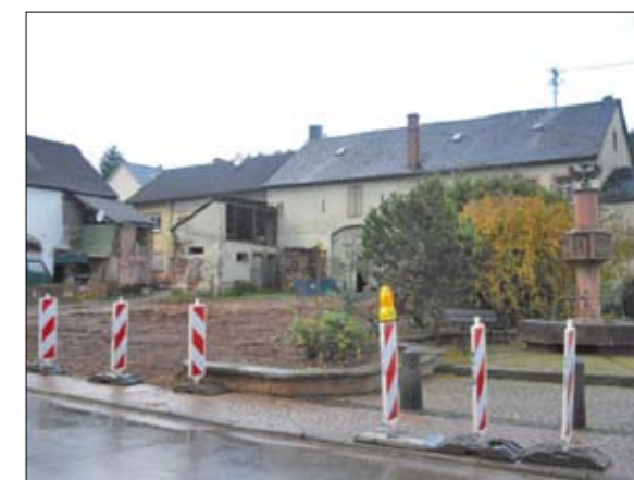
Abb. 15: Ansicht nach Abriss
