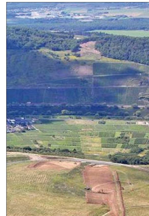
Abb. 3: Blick auf die Trasse der Hochmoselbrücke Quelle: siehe Abb. 1 und 2
