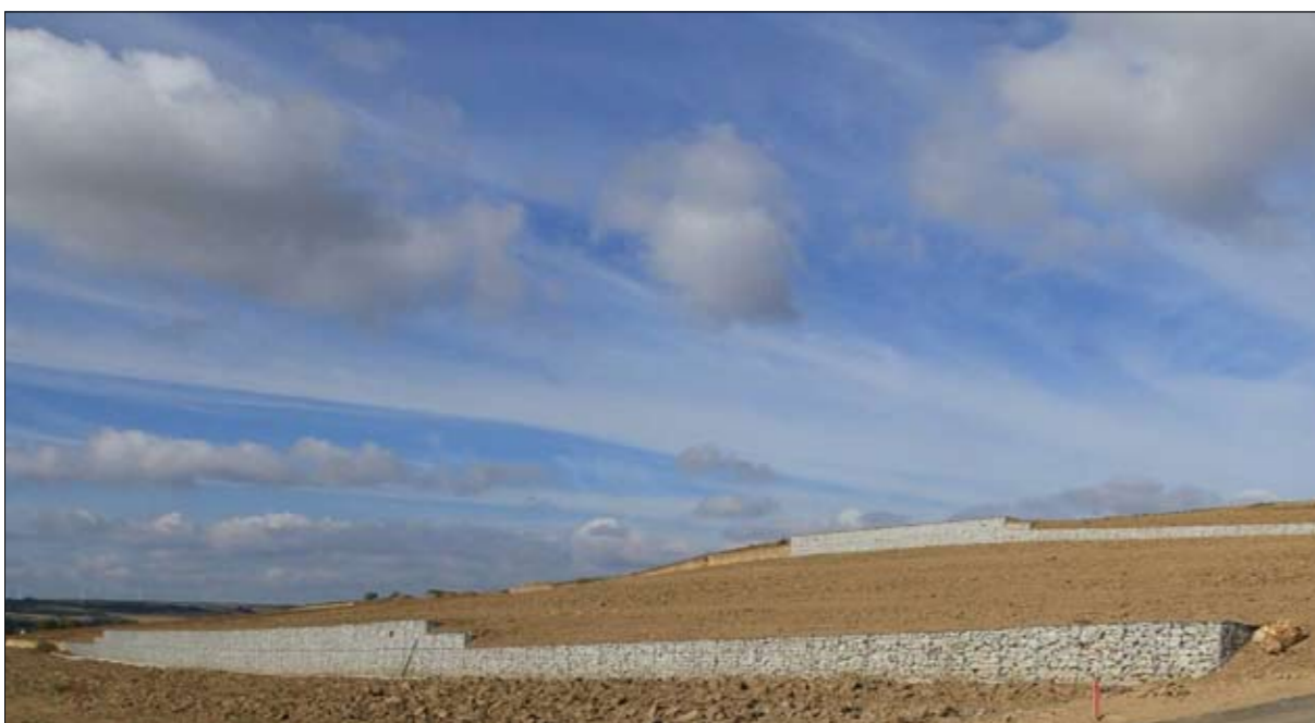
Abb. 19: Nach dem Mauerbau
