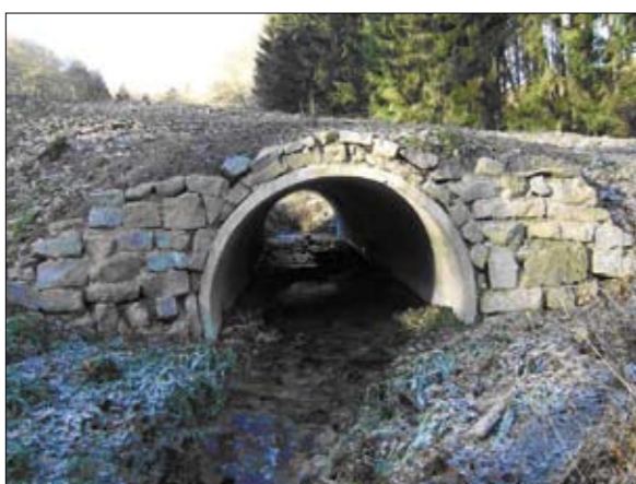
Abb. 30: Erneuerung eines unterdimensionierten Durchlasses
