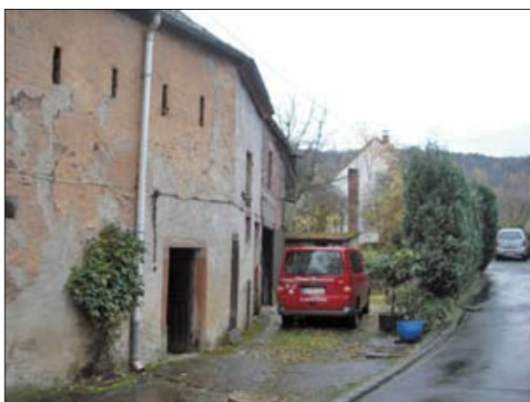
Abb. 10: Haus Nr. 13 vor Abriss
