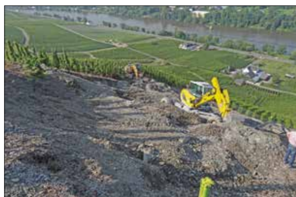
Abb. 7: Vorarbeiten in den Hang
