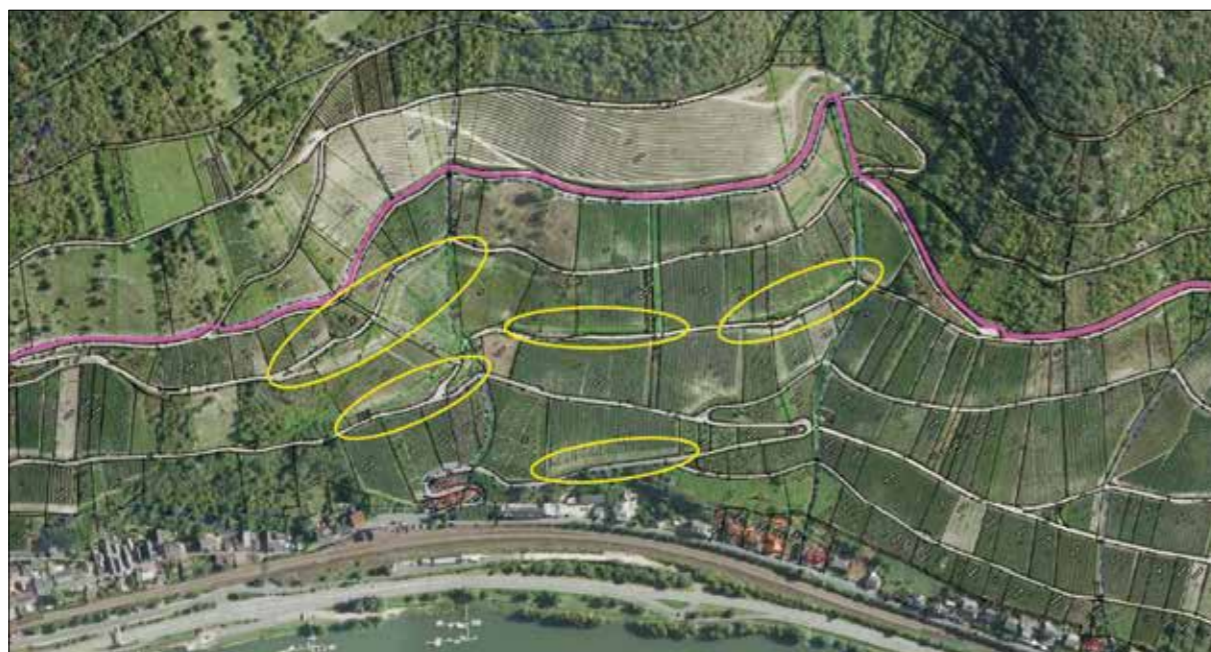
Abb. 12: Luftbild des Neuen Bestands mit den Querterrassen in der oberen Tafel. Darunter der Wildschutzzaun (rosa Linie) und die wegparallelen Vorgewende (gelbe Ellipsen) in der Falllinienbewirtschaftung
