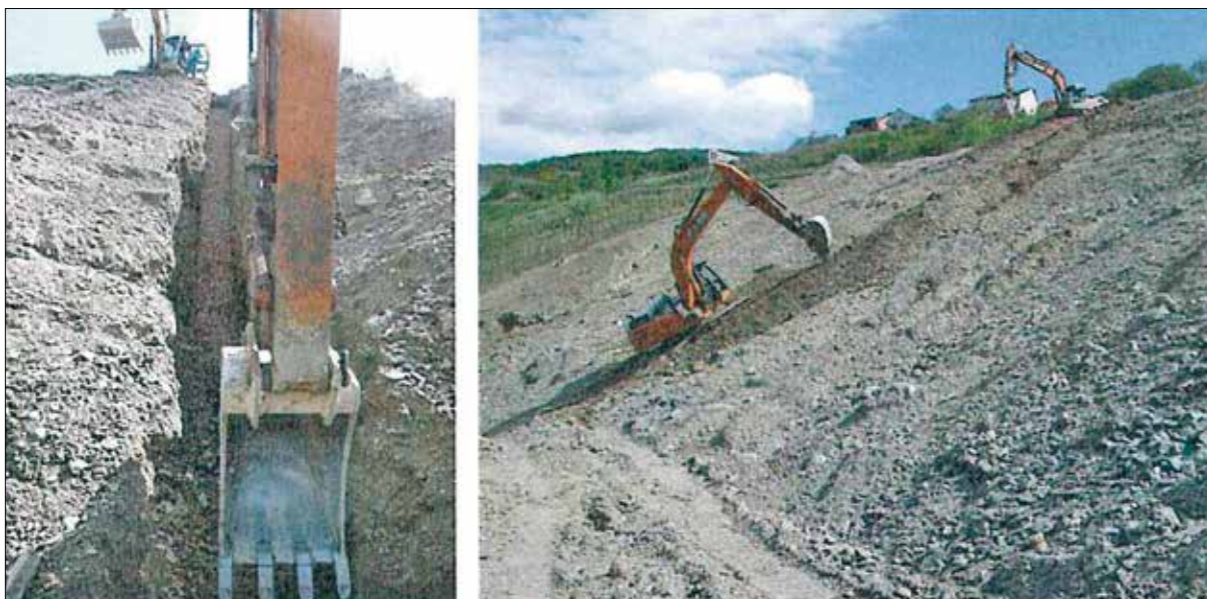
Abb. 15: Baustelle, Arbeiten an der Rigole
