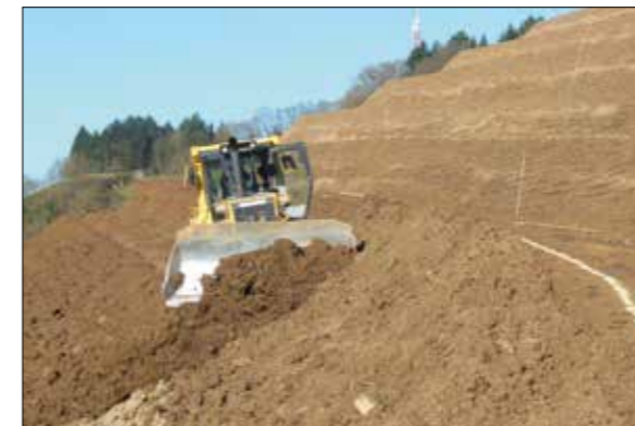
Abb. 6: Erstes Einebnen der Plattform mit Hilfe der Planierraupe
