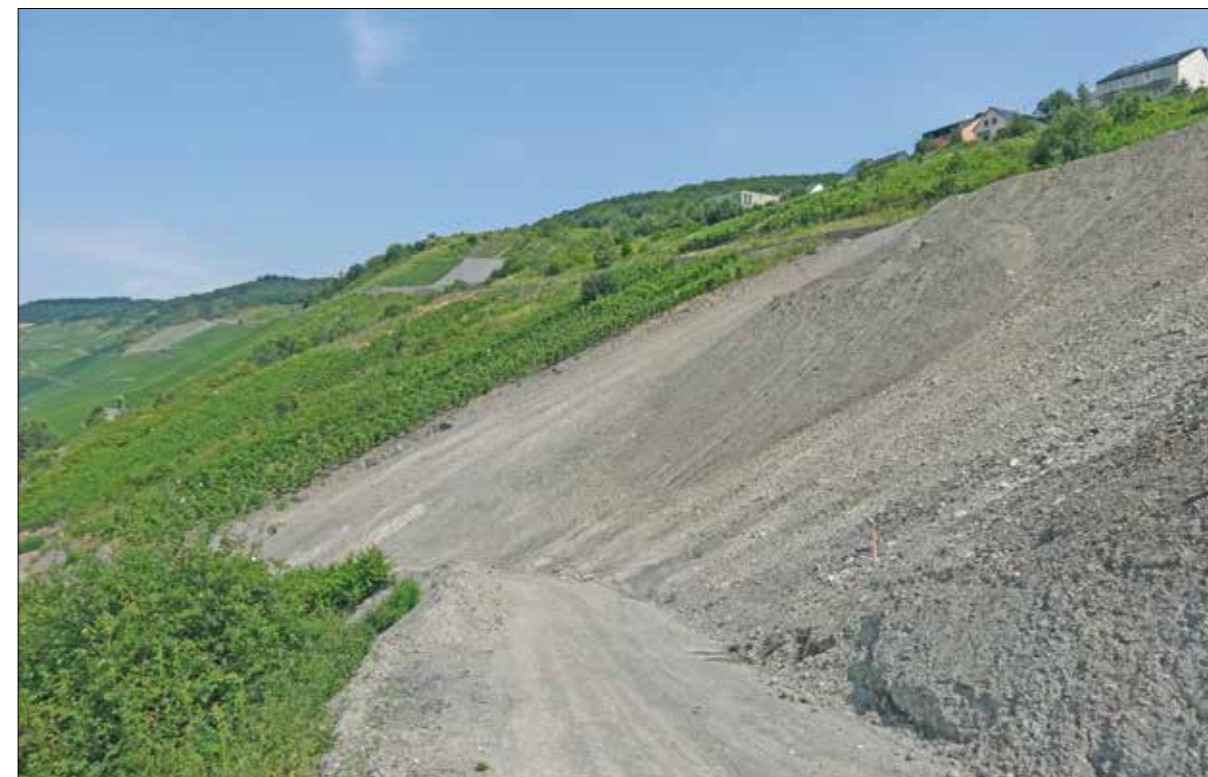
Abb. 17: Fertigstellung der Maßnahme vor Aufbringung des Oberbodens
