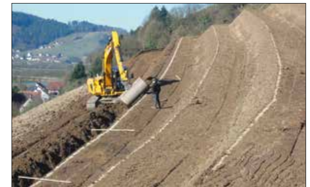
Abb. 7: Abziehen Böschung mit Hilfe des Baggers
