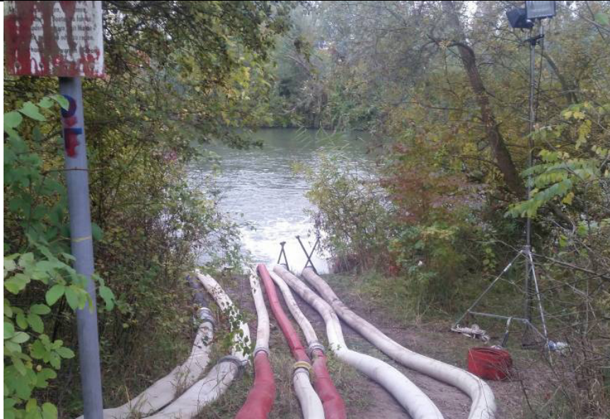
NSG Neuhofener Altrhein und Erweiterung, Havarie des Altwassers, Zuleitung von Wasser aus benachbartem Gewässer September 2015 (P. Fürwitt)
