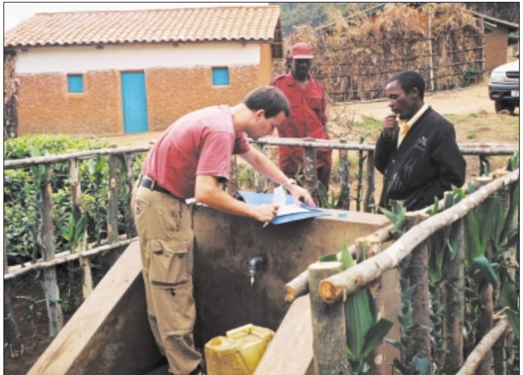
Peter Michel bei der Abnahme einer Wasserzapfstelle (Foto: Peter Michel)
