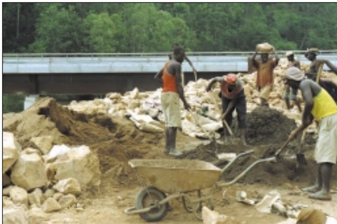
Im Straßenbau gab es in der jüngsten Zeit Bau- und Renovierungsprojekte, die für ein Wachstum der ruandischen Wirtschaft gesorgt haben (Foto: Harald Goebel, LMZ)
