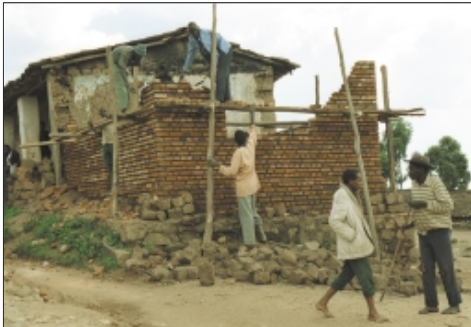
Arbeiter beim Bau eines Hauses mit gebrannten Ziegeln (Foto: Harald Goebel, LMZ)
