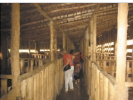
Der neu gebaute Schweinestall (Foto: André Vanneste)
