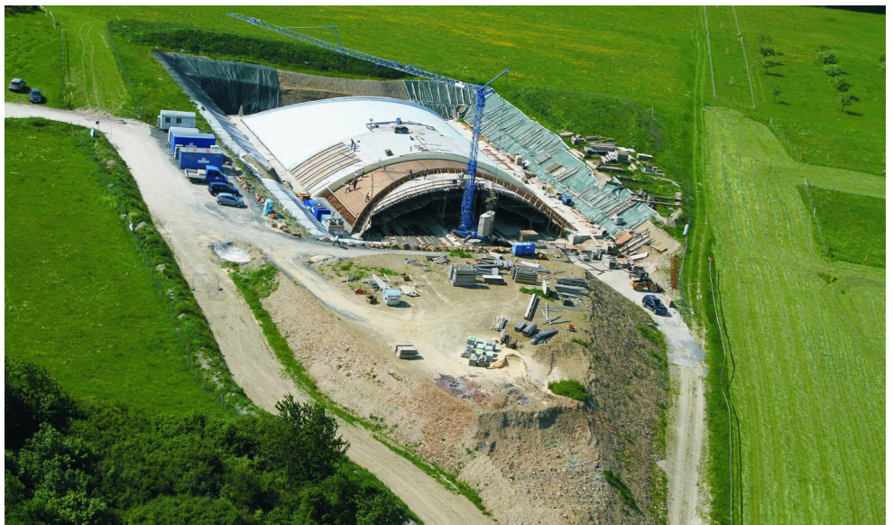
Noch lässt sich lediglich erahnen, dass dieses Bauwerk bald eine Querungshilfe für Tiere sein wird.
