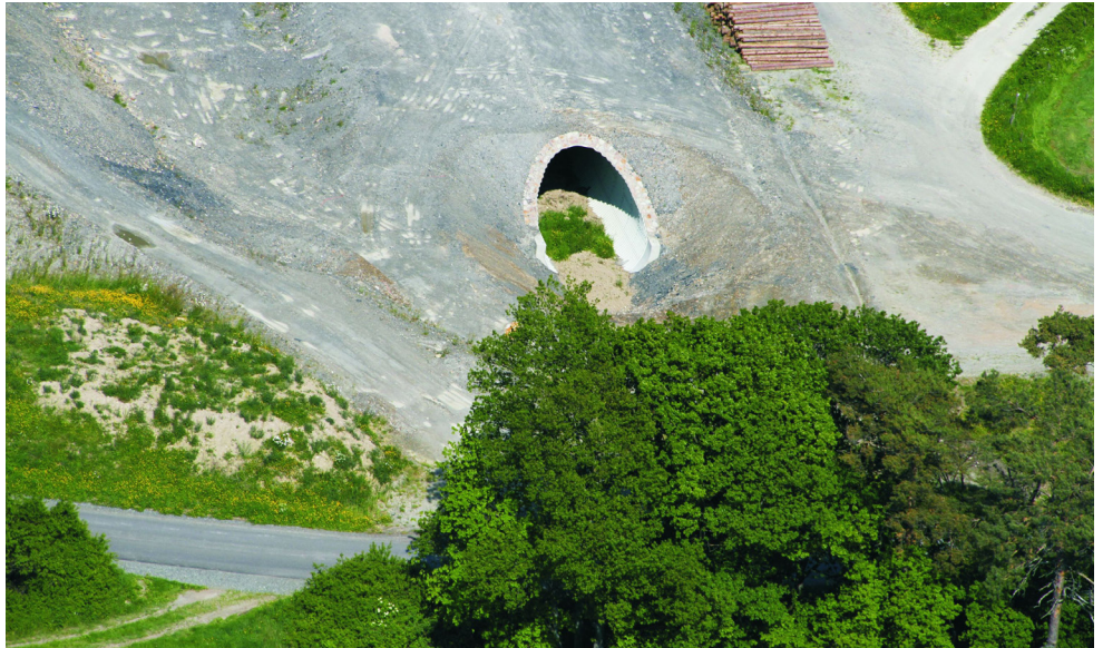
Ein kleiner Tunnel führt hier unter der Trasse hindurch. Es handelt sich um eine Querungshilfe für Fledermäuse.
