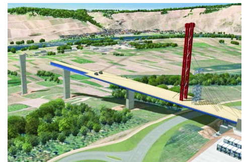
Einschub des Überbaus in 160 Metern Höhe.
