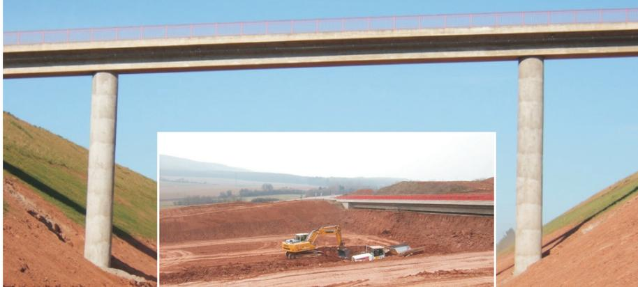
Der Überbau liegt auf der Erde, die Pfeiler sind noch „versteckt“ (kleines Bild). Rund 17 Meter Erde mussten abgetragen werden, um die Brücke „freizulegen“ (großes Bild).
