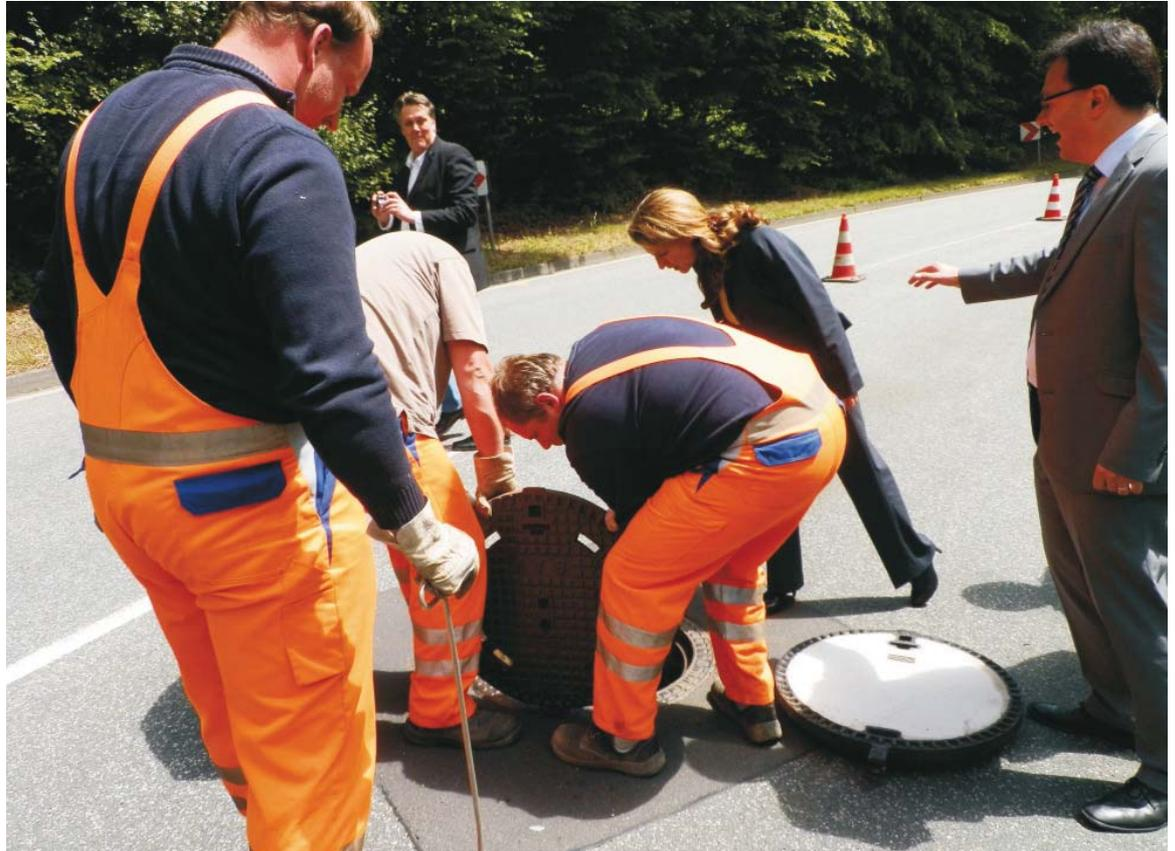
Staatssekretärin Heike Raab tauschte mit Mitarbeitern der SM Dierdorf (MSM Neuwied) insgesamt fünf Schachtdeckel auf der B 413 im Saynbachtal aus. Die neuen Deckel bestehen überwiegend aus Beton. Damit wird verhindert, dass Motorradfahrer bei Nässe ins Rutschen geraten.
