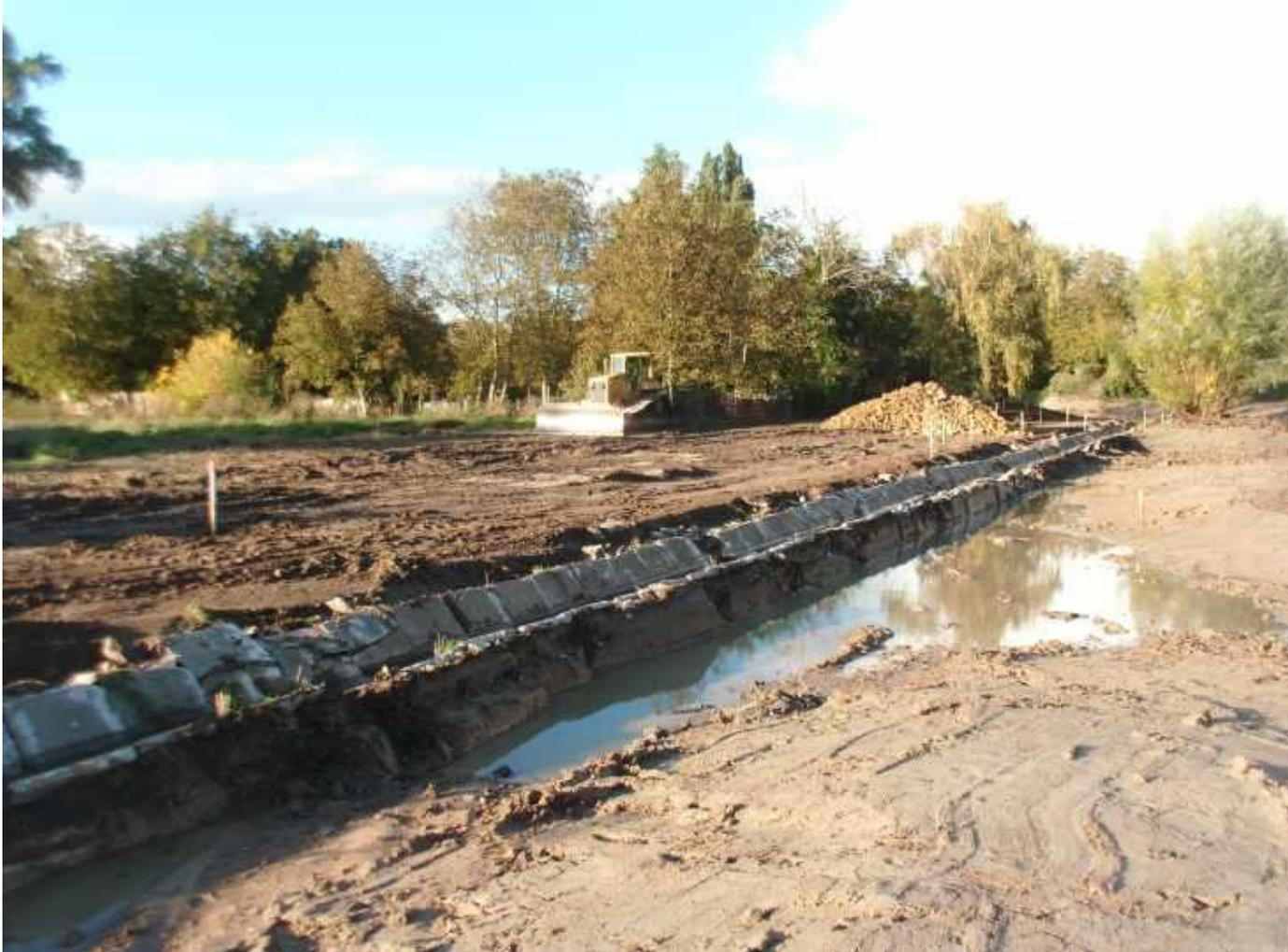
Sohlschalen zur Wasserhaltung – Aus- und Einbau in kleinen Abschnitten
