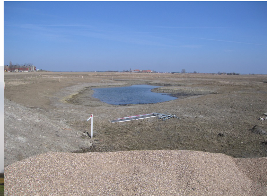
Renaturierung Seegraben Baumaßnahme 1. Bauabschnitt (BA) 2005
