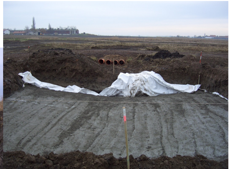
Renaturierung Seegraben Baumaßnahme 1. Bauabschnitt (BA) 2005
