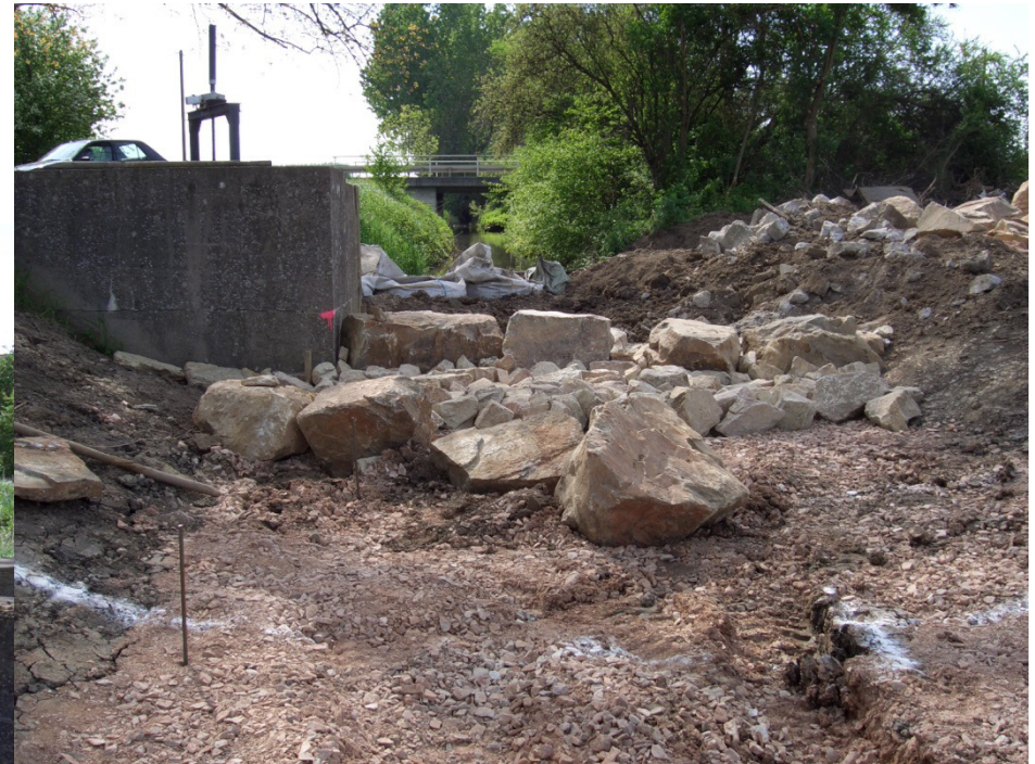
Renaturierung Seegraben Baumaßnahme 1. Bauabschnitt (BA) 2005
