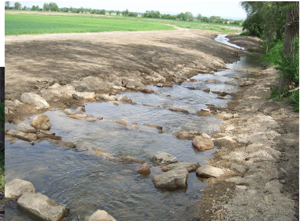
Renaturierung Seegraben Baumaßnahme 1. Bauabschnitt (BA) 2005
