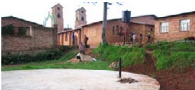
Während der Bauarbeiten: Unterirdische Zisterne mit Vorfilterkammer und Solarpumpe (Vordergrund) speichert Regenwasser von den Dachflächen der Kathedrale (Hintergrund). Strom und Wasserleitungen zum Wasserkiosk gelegt.
