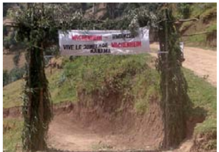
Neu angelegte Straße zur Schule in Rwanzuki
