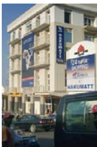
„Das Union Tradecenter und der neue Supermarkt „Nakumatt“ sind Symbole des wirtschaftlichen Aufstiegs“. (Foto: Olga Staudacher)
