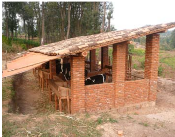
Ein bereits durch das Landwirtschaftsprojekt realisierter Stall mit trächtigen Kühen.
