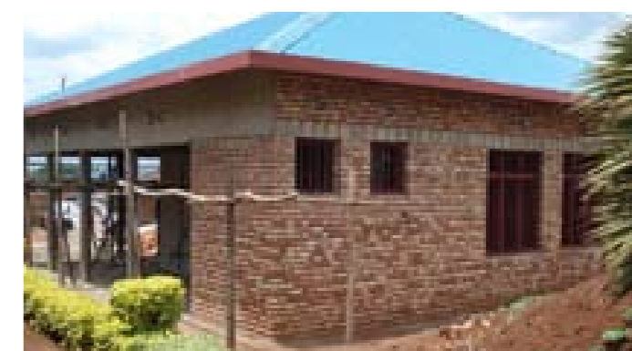
Zahnklinik im Rohbau (Foto: Steven Smits)
