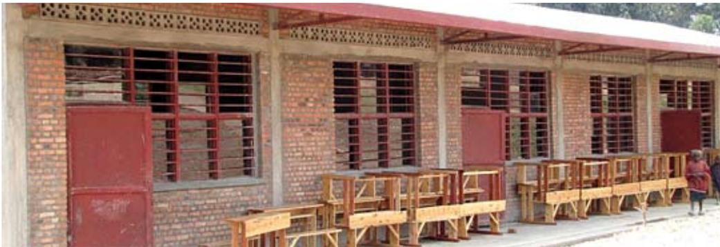
Hier gut sichtbar die Ständerbauweise: auf dem Fundament ruht ein erster Ringanker, dann die Pfeiler mit denen die Dachkonstruktion aus Metall verbunden ist. Über den Fenstern der zweite Ringanker mit einer größeren Belüftungsfläche (durchbrochene Mauersteine) umlaufende Dachrinne aus Metall.
