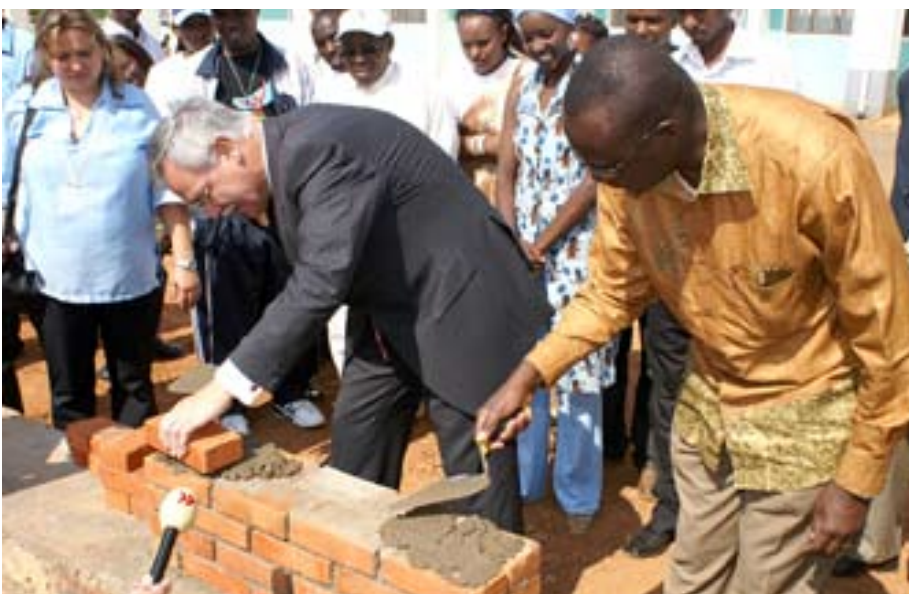
Auch der damalige Minister Karl Peter Bruch griff zu Kelle und Mörtel für den Bau einer Sporthalle für Menschen mit Behinderung.
