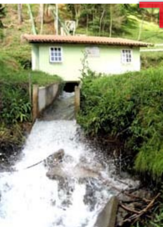
Typisches Turbinenhaus für PaT – Anlage (Brasilien) (Foto: KSB AG, Dr. Brodersen)
