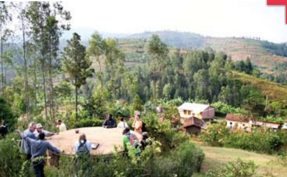
Wasserversorgung Nyabiranga. 1999/2000 gebaut, versorgt sie über 6000 Menschen. Beim Besuch einer Gruppe des Ruanda-Komitees 2006 wird sie besichtigt – hier an einer Zisterne.
