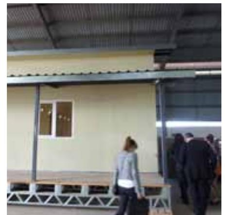
Musterhaus aus gepressten Strohplatten der Firma STRAWTEC.
