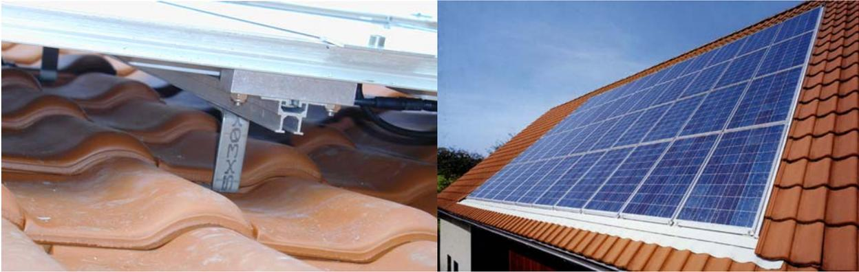
Abbildung 3-2: Auf-Dach-Montage (links) und In-Dach-Montage (rechts)<sup>5</sup>
