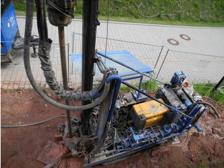
**Abb. 17 Bohrung einer Erdwärmesonde**
