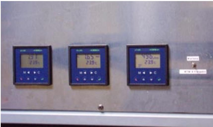
Bild 2: Messumformer der neuen Generation
