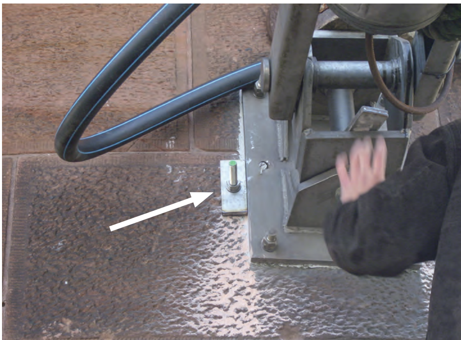
Abb. 11: Lasche nach dem Verschweißen mit der Halteplatte
