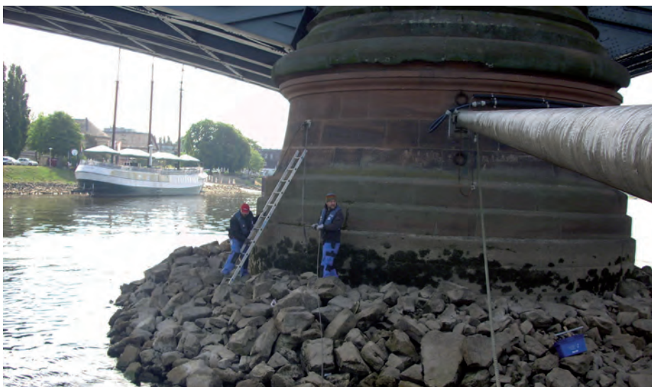
Abb. 8: Befestigung der seitlichen Abspannung
