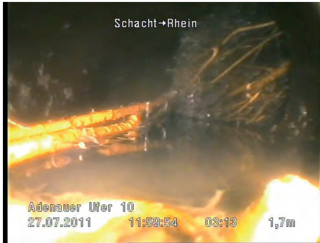
Abb. 14: Einwuchs einer Wurzel im Rohr
