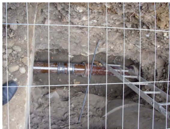
Abb. 18: Kanal nach Reparatur Zustand nach Sanierung
