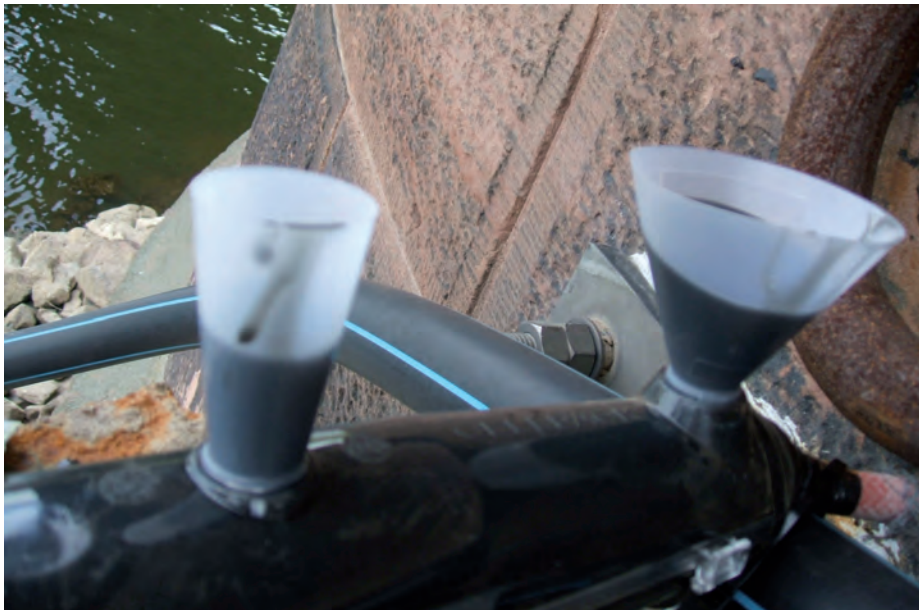
Abb. 10: Gießmuffe zur Reparatur des Versorgungskabels
